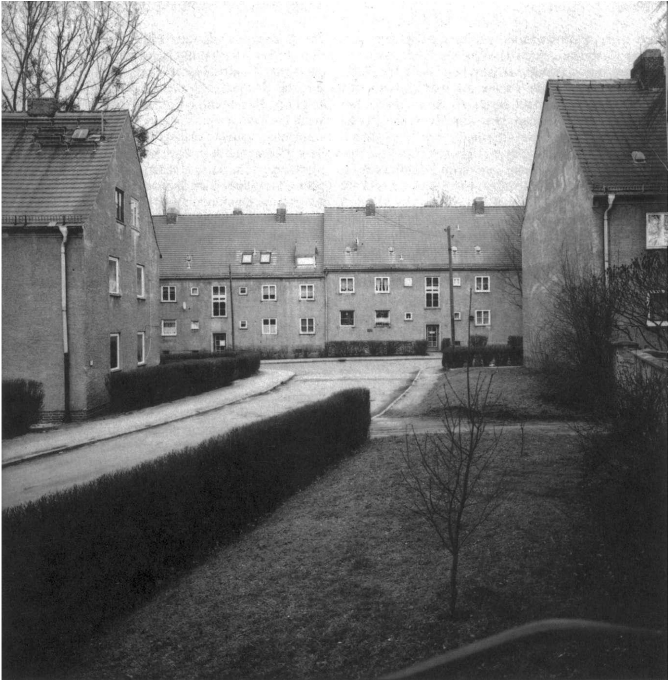
Blick in die Lindenhof-Siedlung.
