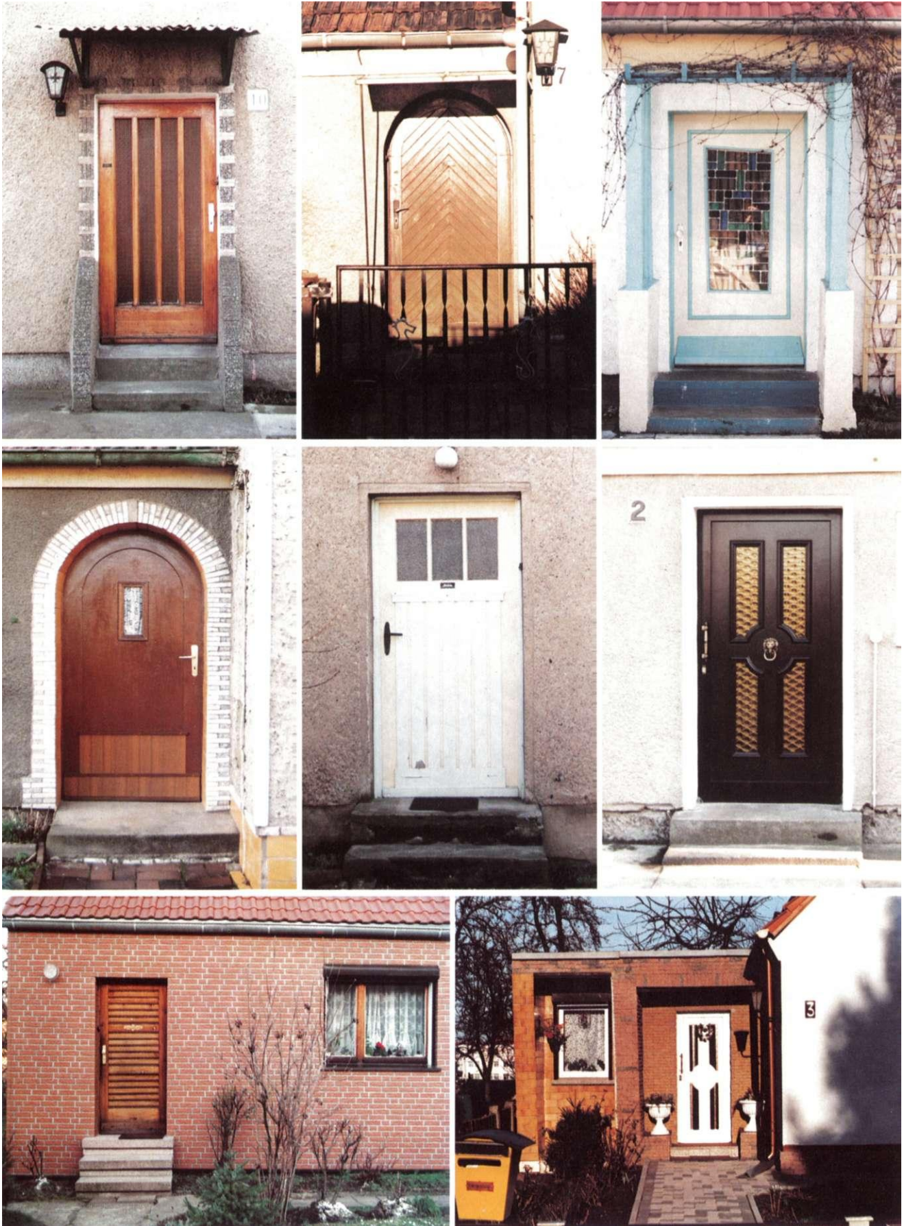
Siedlung Fuchsbreite: Haustüren.
