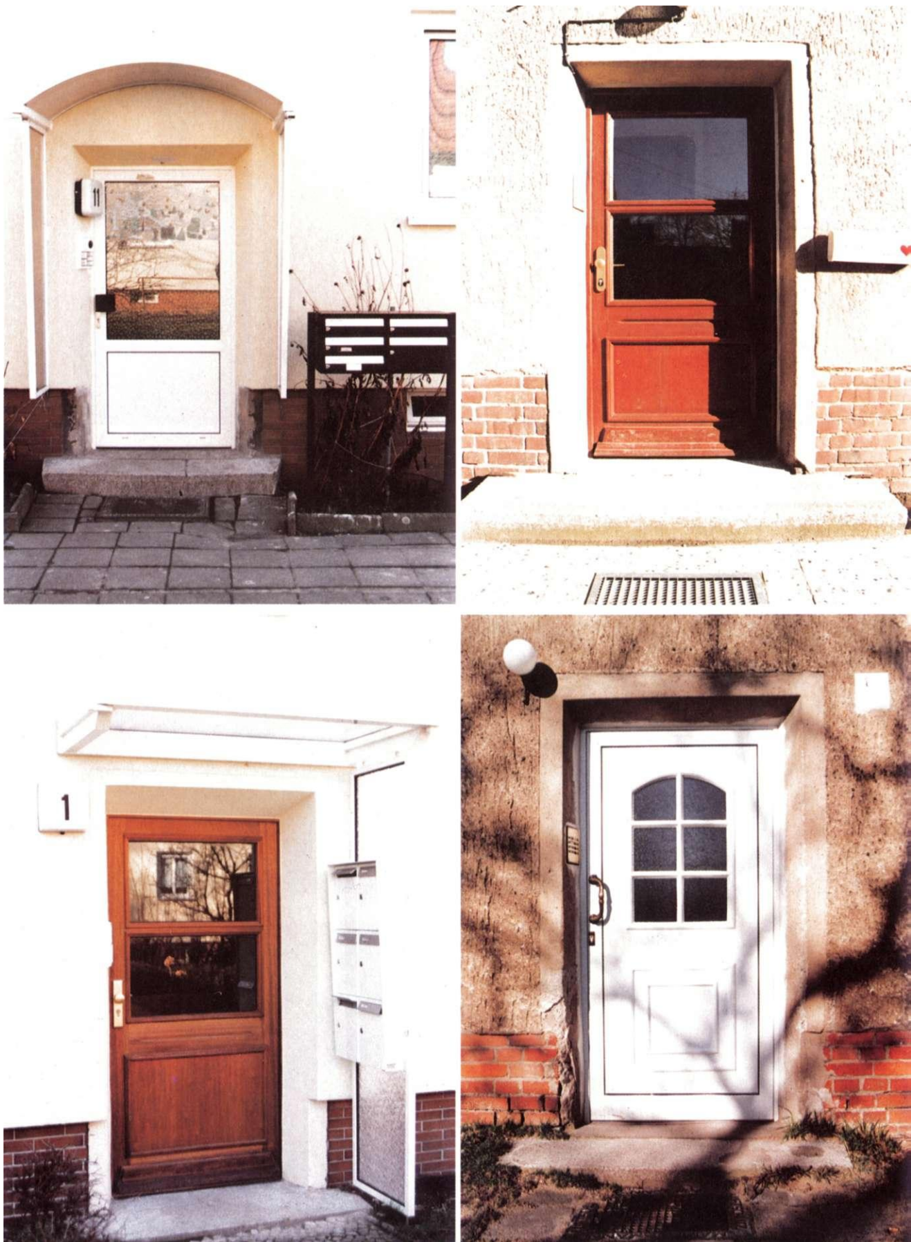
Lindenhof-Siedlung: neue Türen.
