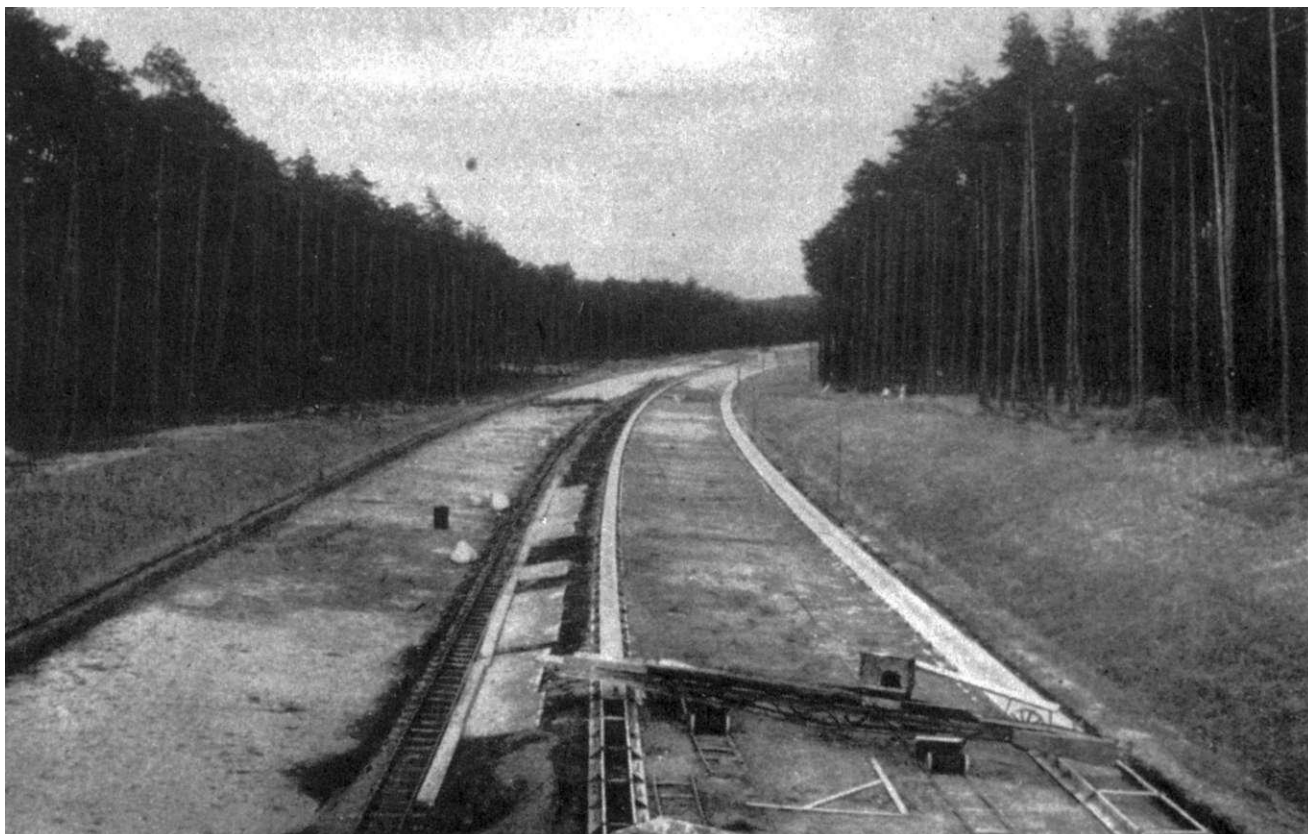
Autobahn Berlin - Hannover. Strecke zwischen Hohenwarthe und Möser. Bauzustand August 1936.
