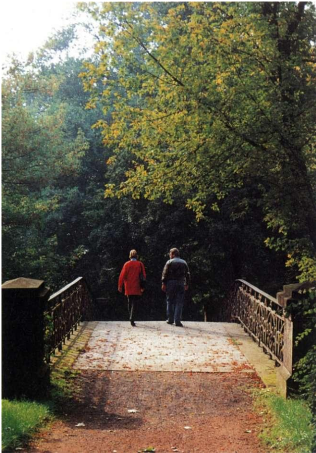
Abb. 109 Detail der Laaß-Brücke
