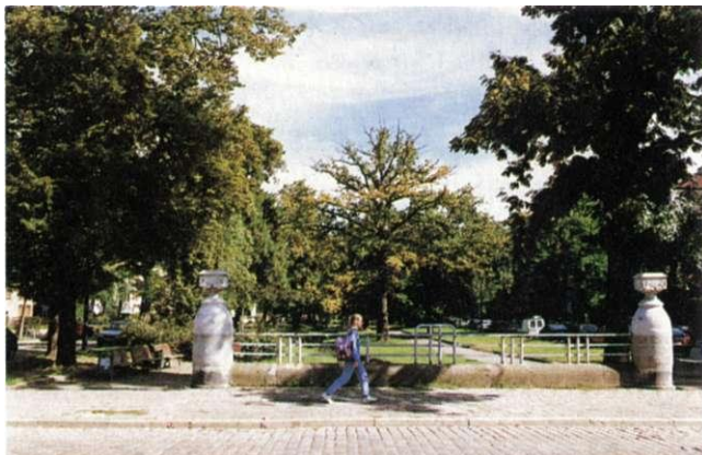
Abb. 142 Verzierte Brücken verbinden die beiden Straßenzüge beiderseits der Schrote
