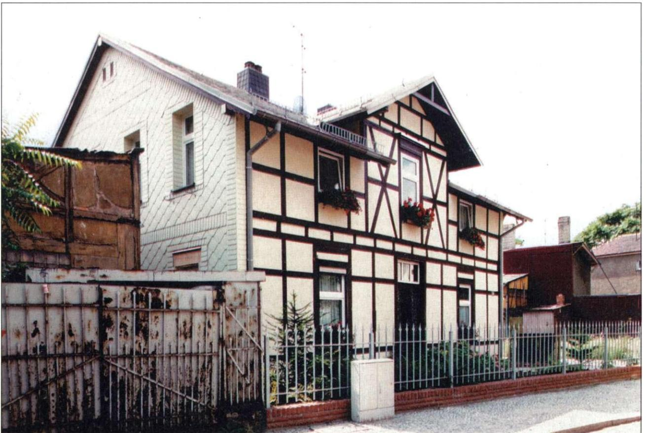
Abb. 109 Stadtfeld, W.-Külz-Str. 21, Zustand 1994; Zerstörerische Eingriffe: Abriß der Gesimsornamentik, Asbestzement, Schablonen am Giebel, Giebelfachwerk, Vordach abgerissen, stillloser Anstrich des Holzes
