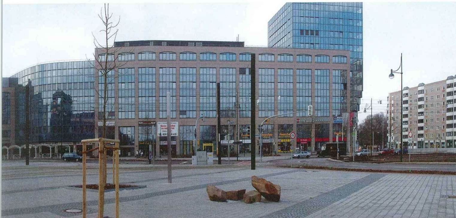
Uniplatz mit neuer Gleisanlage
