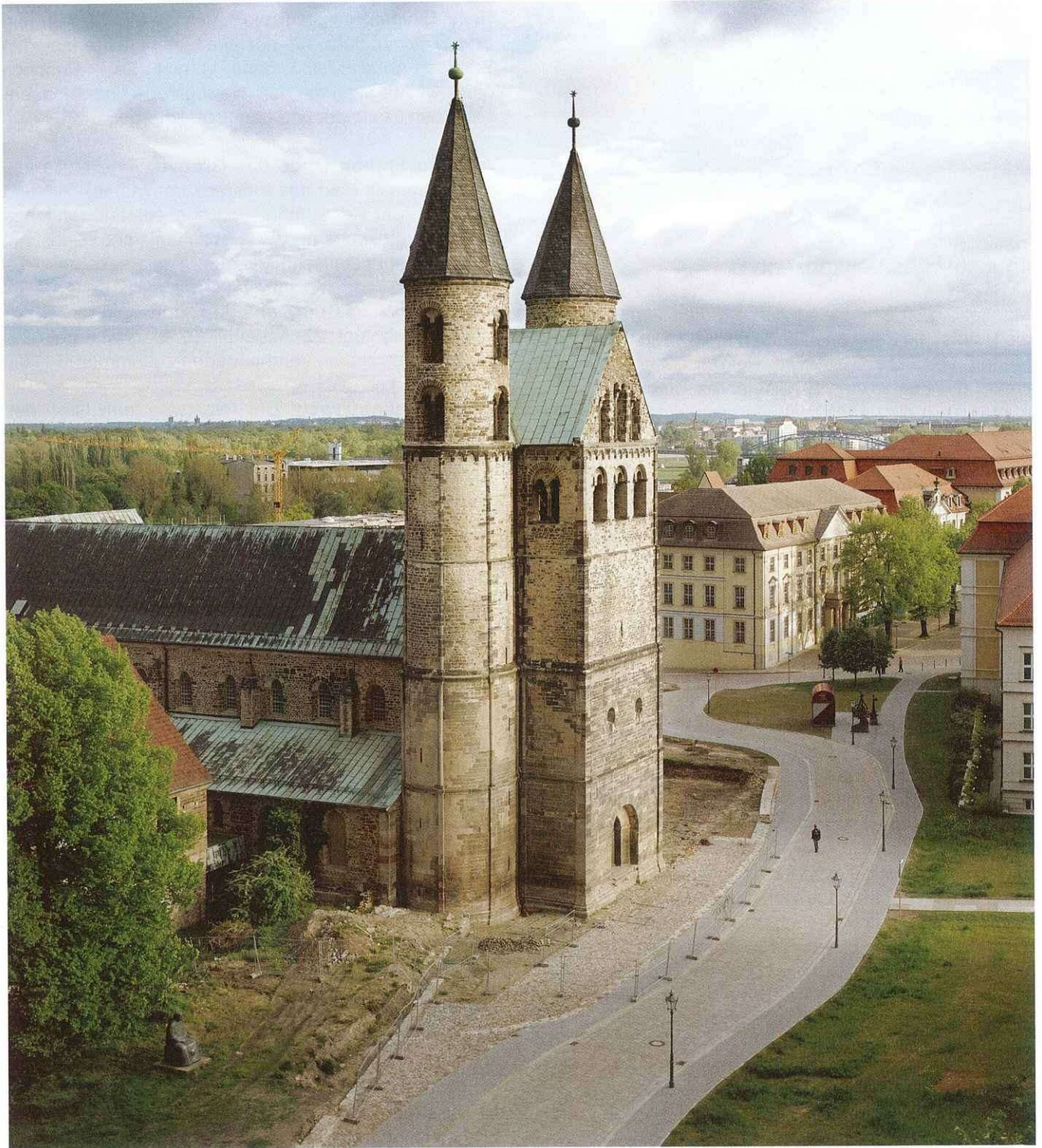
Blick auf das Kloster Unser Lieben Frauen mit der auf das historische Niveau abgesenkten Regierungsstraße
