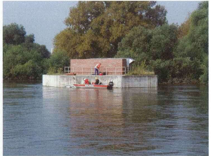
Hochwasser August 2002: Ostschacht
