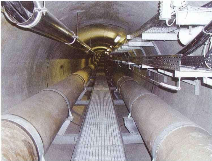
Blick in den Elbtunnel von West nach Ost (HPW nach Ostschacht)
