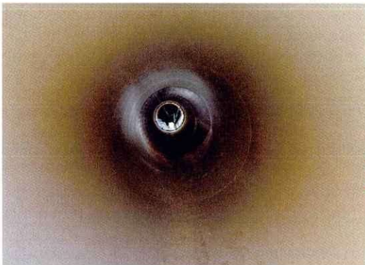
Blick in den neuen Hauptsammler
