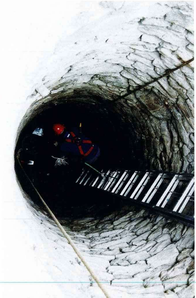
Abb. 10: Der Brunnenschacht wird beräumt
