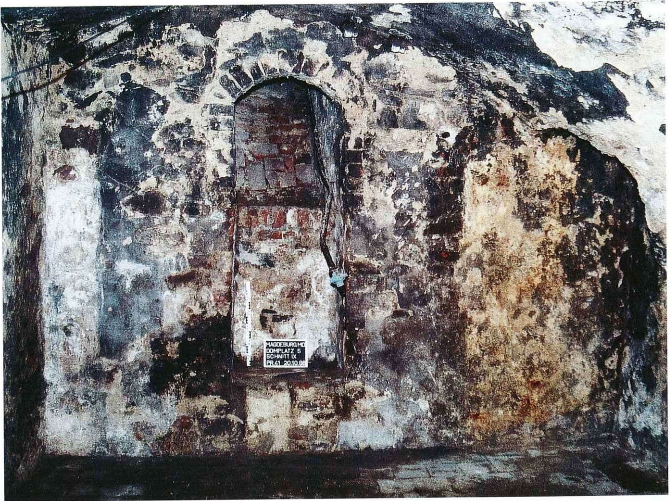
Abb. 12: Innenansicht des Kellers in Domplatz 5. Blick Richtung Westen
