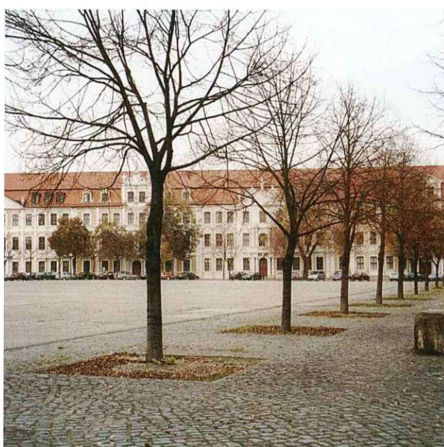
Abb. 12: Landtagsgebäude Sachsen-Anhalt (Gesamtansicht)
