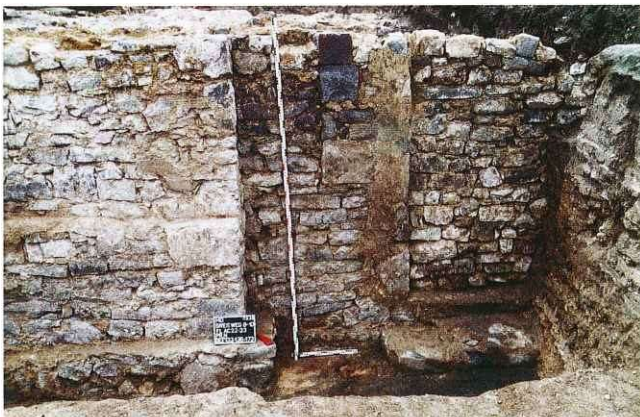
Abb. 21: Vermauerte Tür mit Treppenstufe am re. Bildrand
