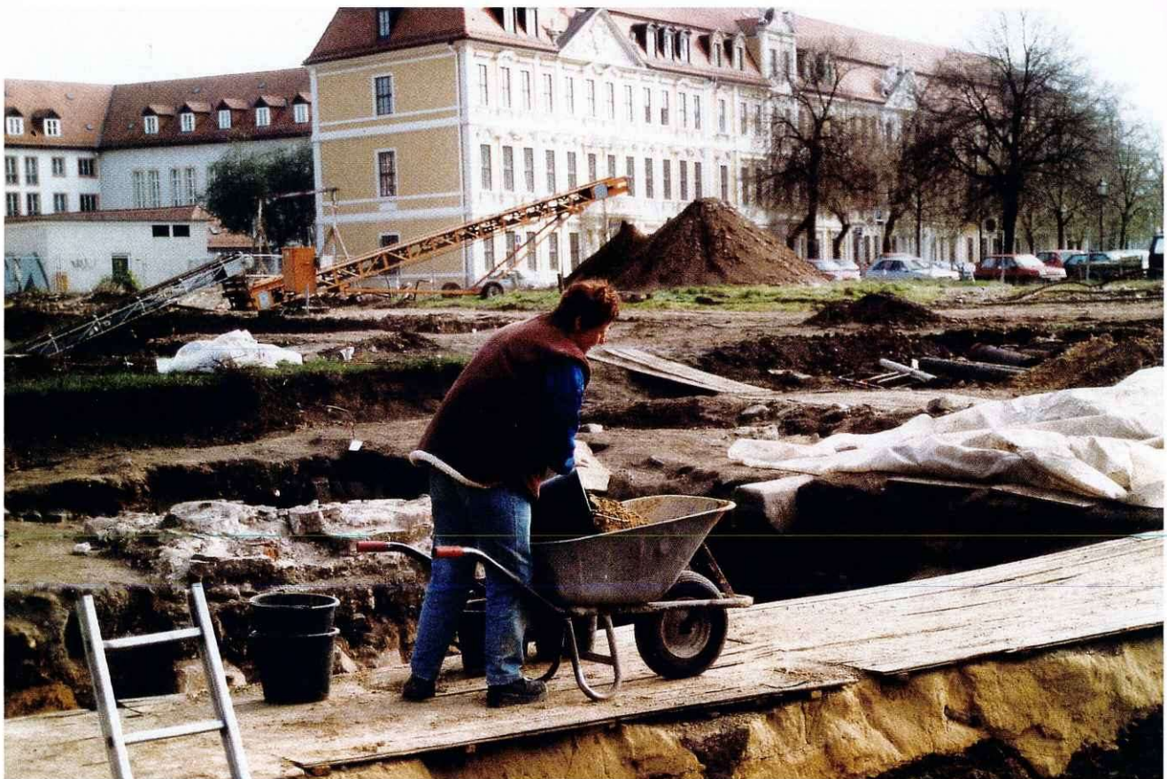
Abb. 5: Ausgrabungsarbeiten am westlichen Domplatz
