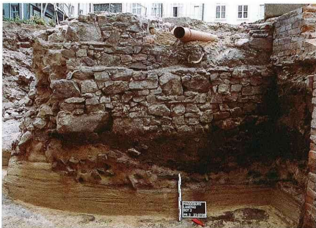
Abb. 5: Älteste gefundene Natursteinmauer in der Nordostecke des Landtag- innenhofes mit darunterliegendem Grubenhaus
