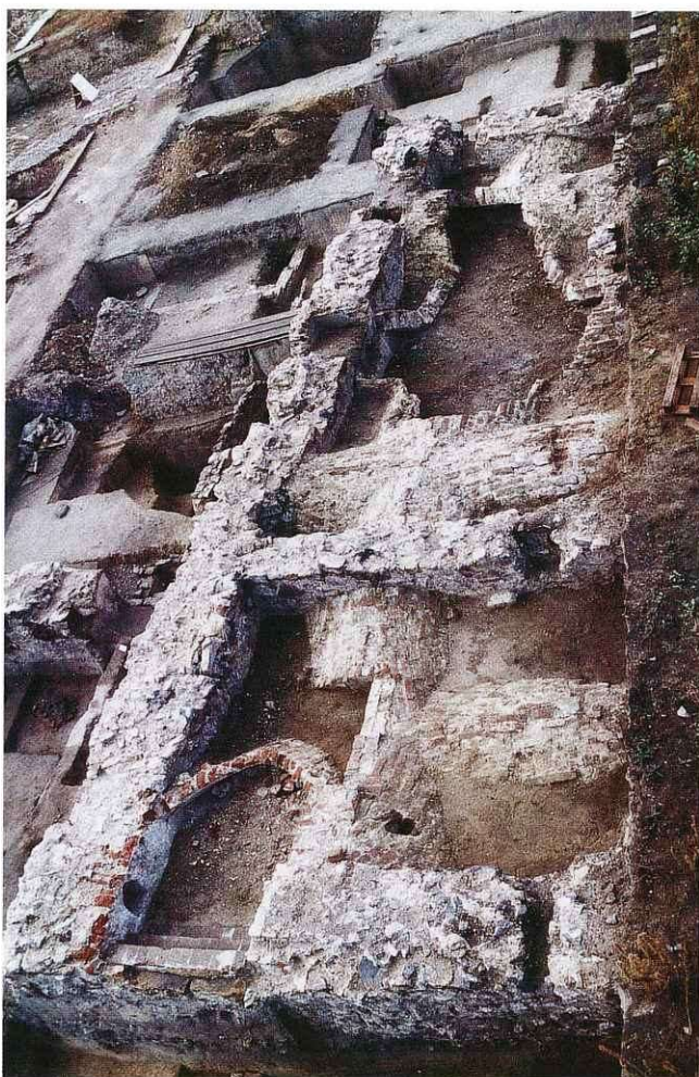
Abb. 6: Fundamentmauerwerk mit zerstörtem Kreuzkappengewölbe
