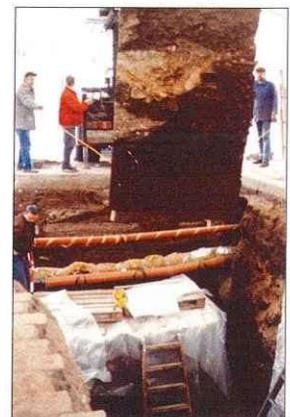
Abb. 2 Nach dem Aushärten der Kunststoffe ließ sich das Profil in Teilstücken von der Wand lösen. Bei der Abnahme zeigte sich, dass das Kunstharz tief in die Erdschichten eingedrungen war.
