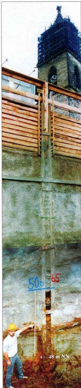
Bild 2 (oben) Aufschluss des Felsgesteins in der Baugrube der Norddeutschen Landesbank am Domplatz
