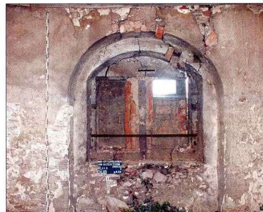
Abb. 38 Westwand des 1. Obergeschosses mit dem rekonstruierten Verlauf des primären Ziegelgewölbes.
