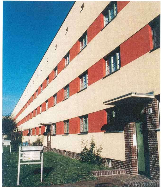
Beims-Siedlung: Walbecker Straße
