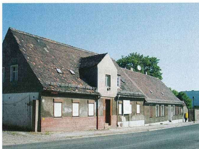
Ländliches Wohnhaus in der St. Michael-Straße
