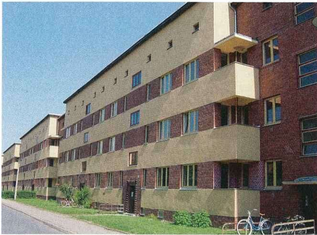
Siedlung Cracau: Mehringstraße
