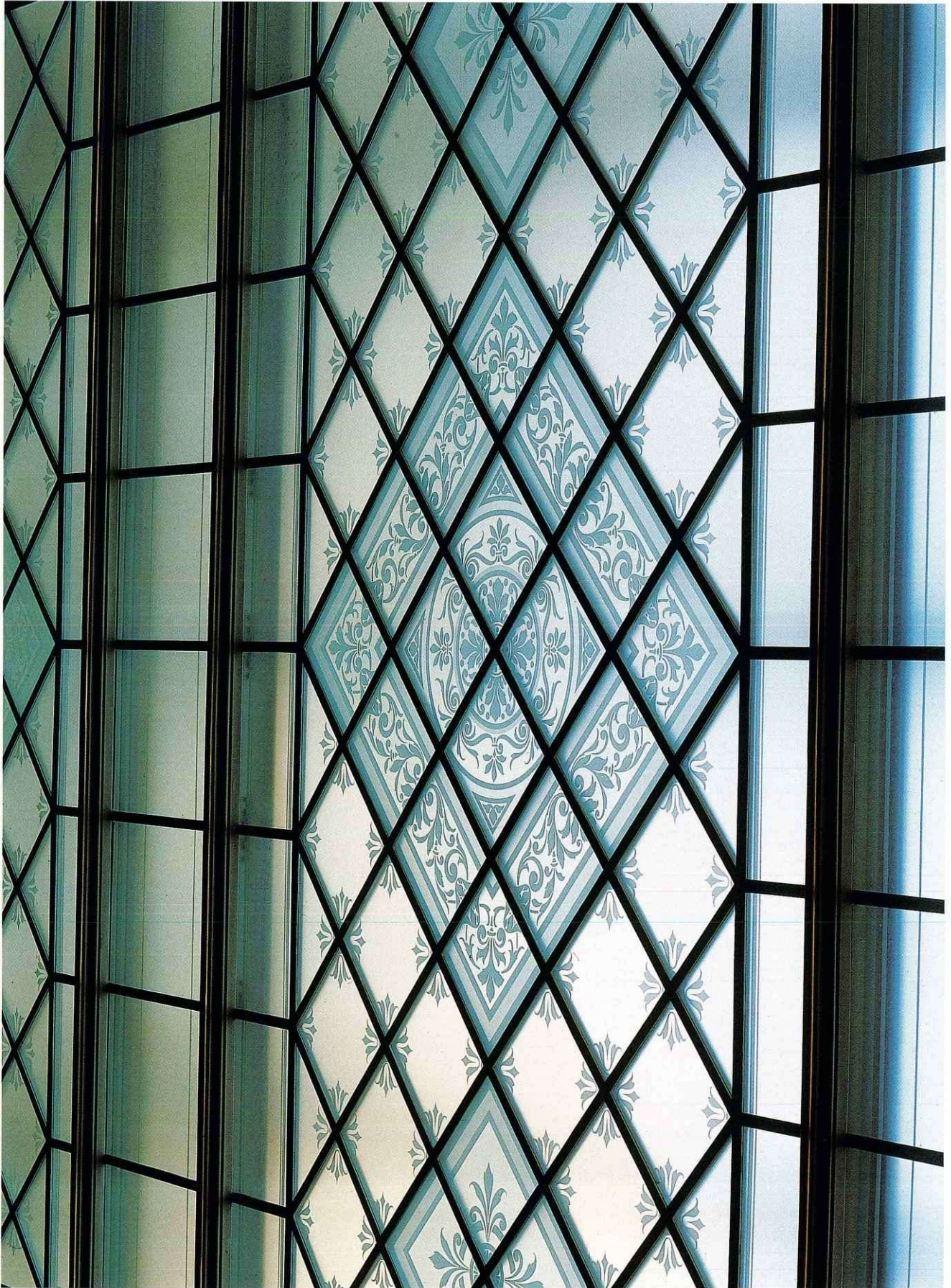
Glasoberlichtdecke mit dreistufiger Flußsäure-Ätzung
