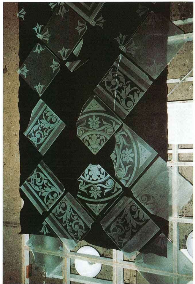
Staatskanzlei Sachsen- Anhalt Magdeburg, Hegelstraße Mitarbeit am Restaurierungsprojekt Glasoberlichtdecke Wiedergefundene Restscheiben
