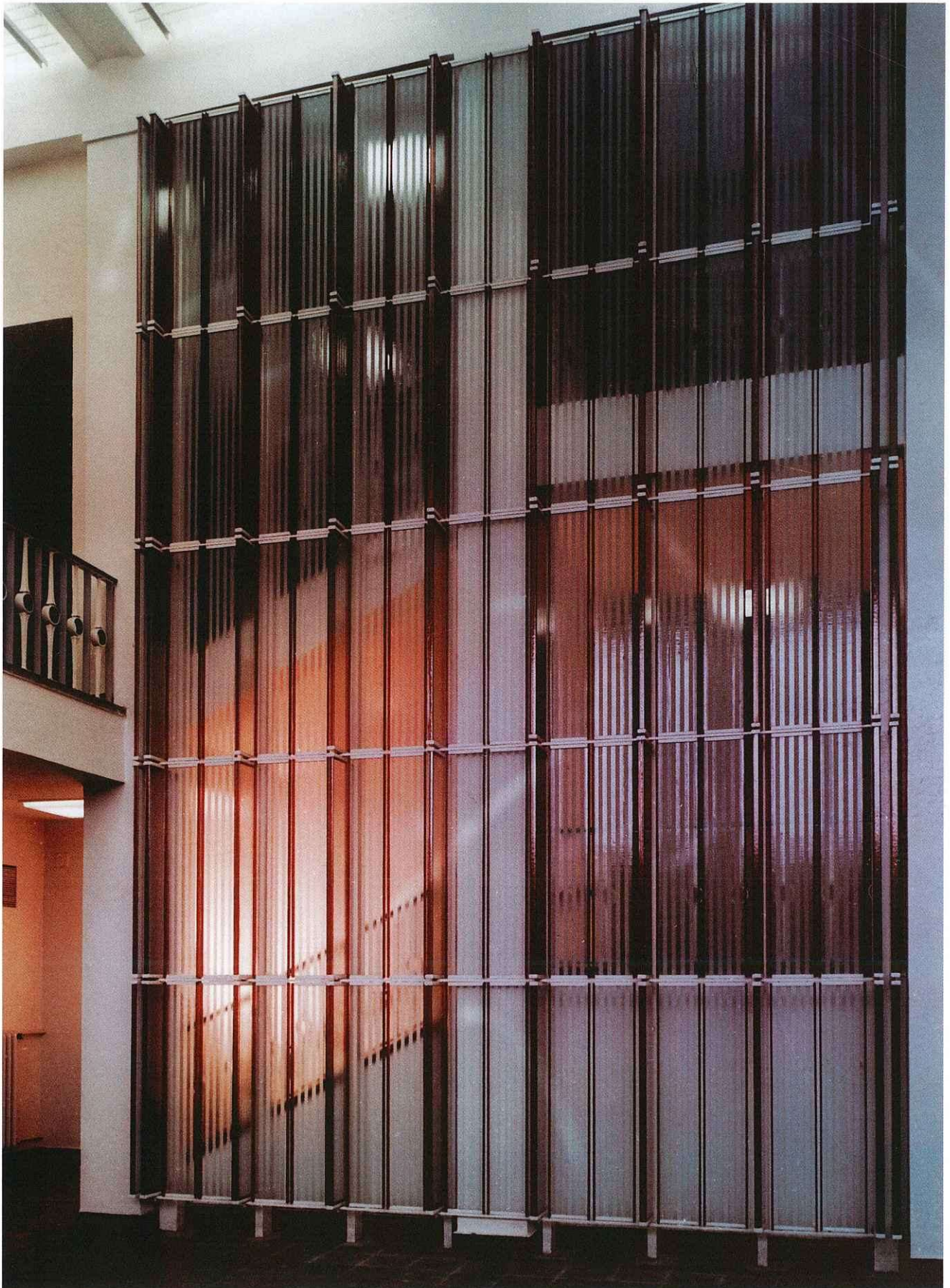
Werner- Seelenbinder- Halle Berlin: Trennwände im Eingangsbereich. Entwurf: Richard Wilhelm 1967, U- Strangprofil „Copilit“ Sandstrahl , Farbglassapplikation.
