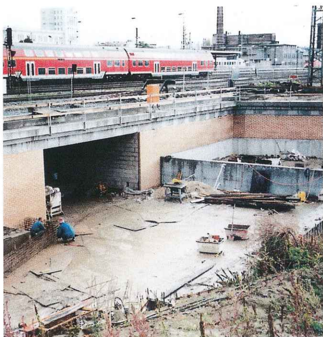
Bahnhofspassage - Bauphase - Eingang und zukünftige Fahrradabstellanlage
