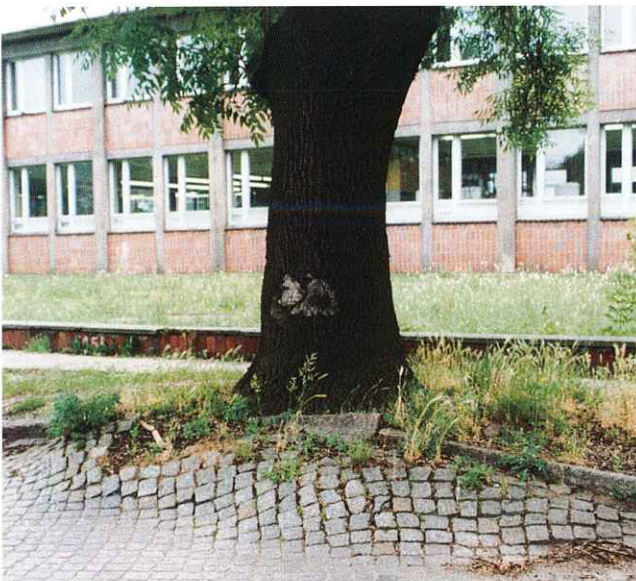
Maybachstraße vor dem Ausbau
