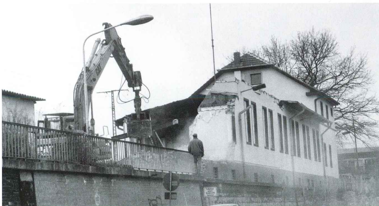
Abriss der Flachbauten unmittelbar neben der heutigen Gaststätte Maybachstraße 25
