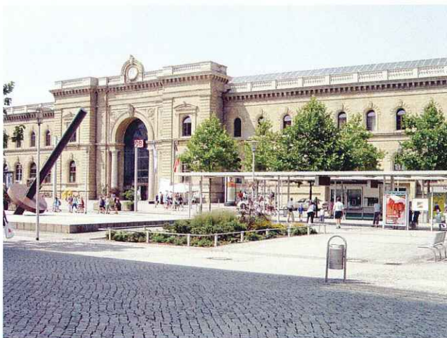
Bahnhofsvorplatz mit Straßenbahnhaltestelle heute
