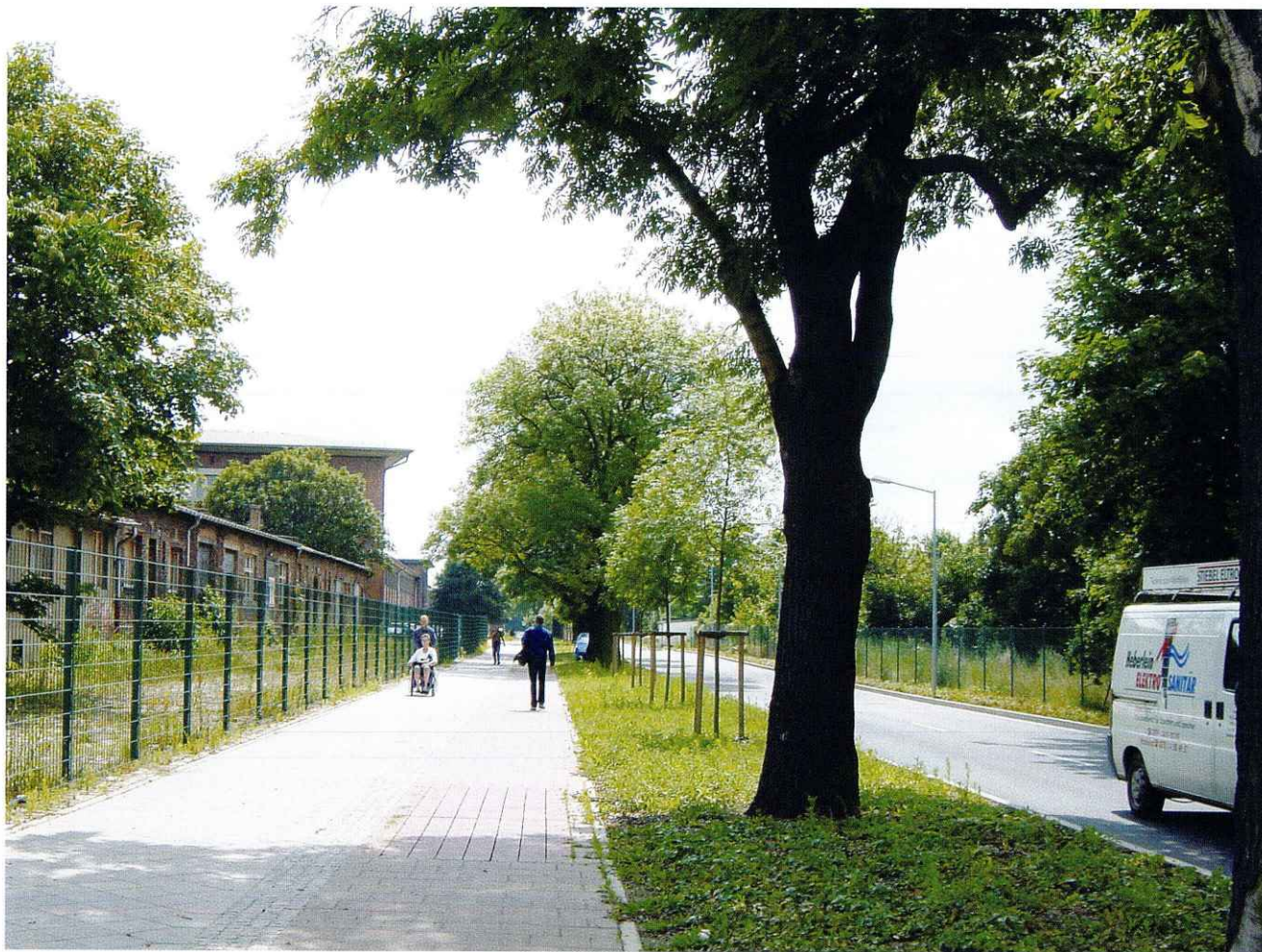
Maybachstraße nach Fertigstellung - heute
