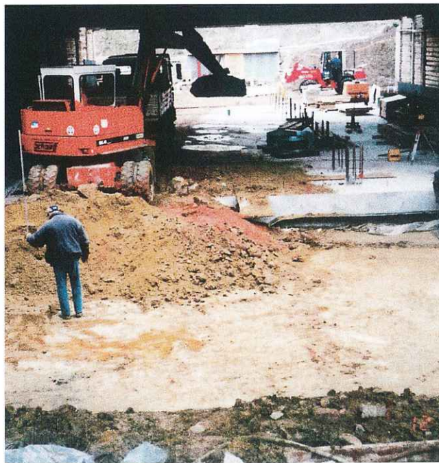
Baufortschritte in der Passage
