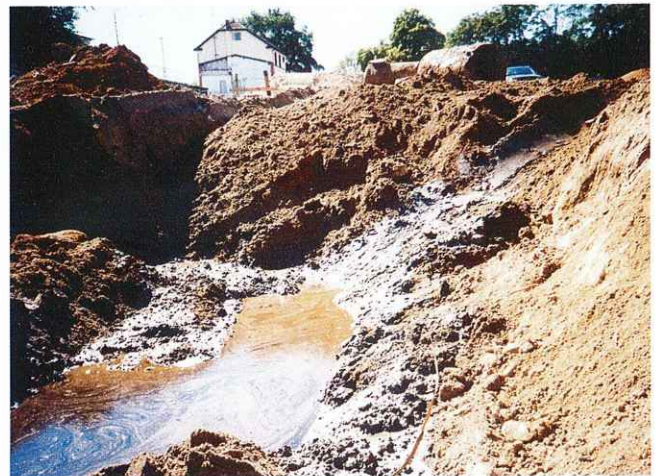
aufgefundene Altlasten beim Bau des ZOB
