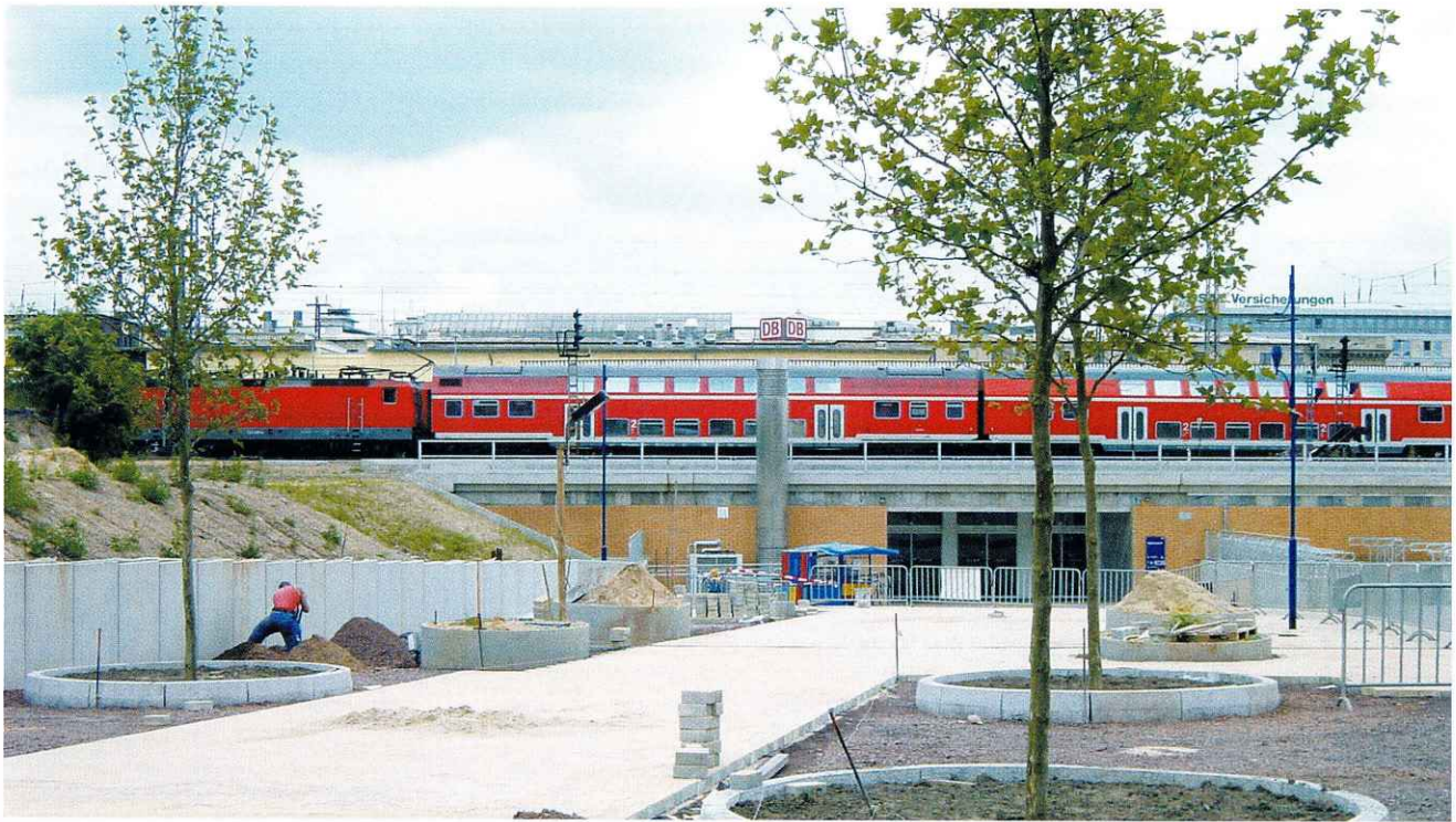
Bau des Stadtplatzes Juli 2002
