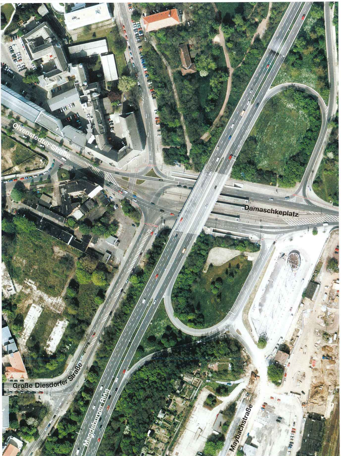
Schnittstelle Magdeburg Hauptbahnhof - April 2000
