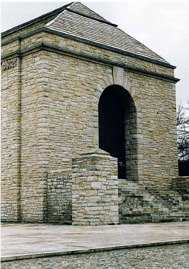
Fahnenhalle der ehemaligen Hindenburg-Kaserne, Eingangsbereich
