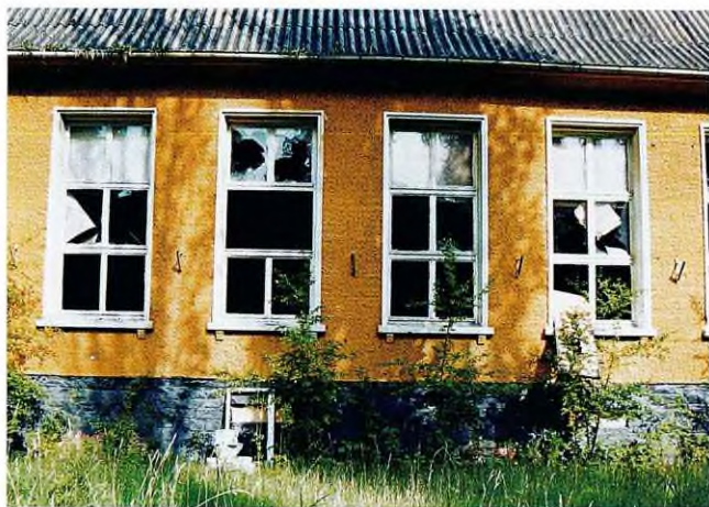
Flak-Kaserne an der Thomas-Mann-Straße, Wirtschaftsgebäude mit Kasino und Speisesälen, Detail vom nördlichen Speisesaal
