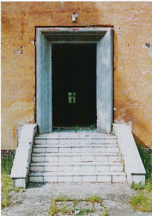
Flak-Kaserne an der Thomas-Mann-Straße, Eingang in der Stirnseite eines Mannschaftsgebäudes
