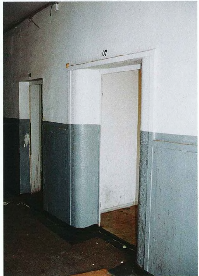
Flak-Kaserne an der Thomas-Mann-Straße, Flur im Mannschaftsgebäude, Detail
