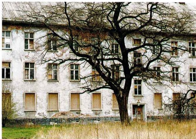
Luitpold-Kaserne, Mannschaftshaus, heutiger Zustand
