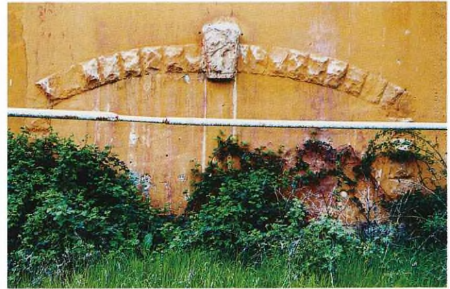
Flak-Kaserne an der Thomas-Mann-Straße, vermauerte Durchfahrt am Mannschaftsgebäude
