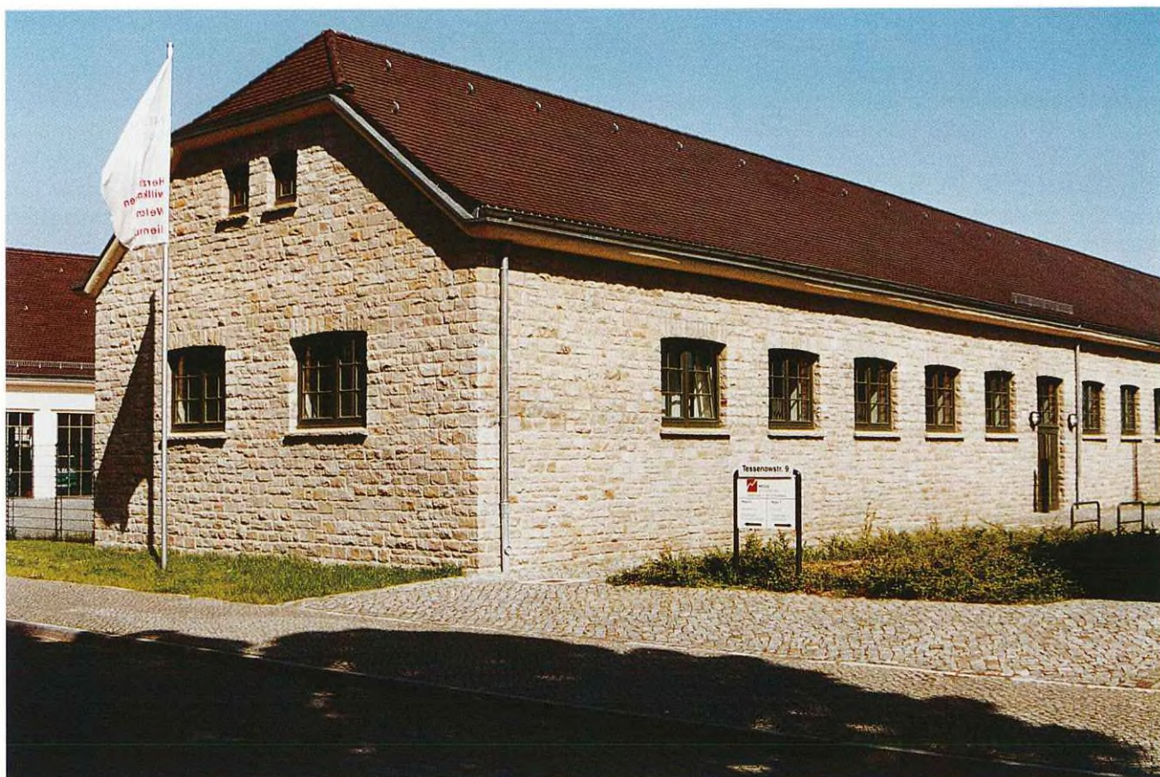
Hindenburg-Kaserne, Wagenhalle auf der Nordseite
