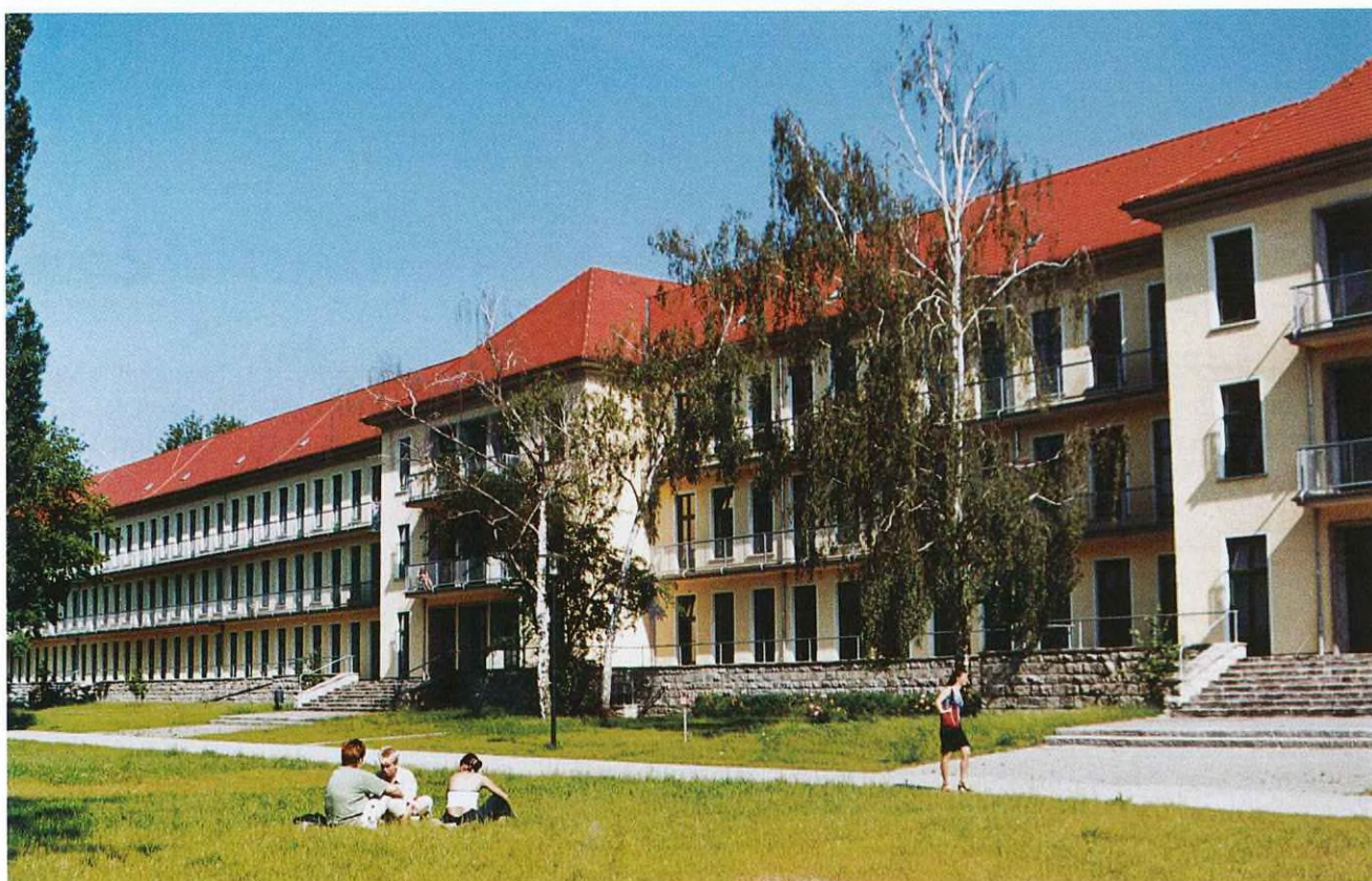
Standortlazarett in der Breitscheidstraße, heute Fachhochschule, rückwärtige Ansicht des früheren Bettenhauses
