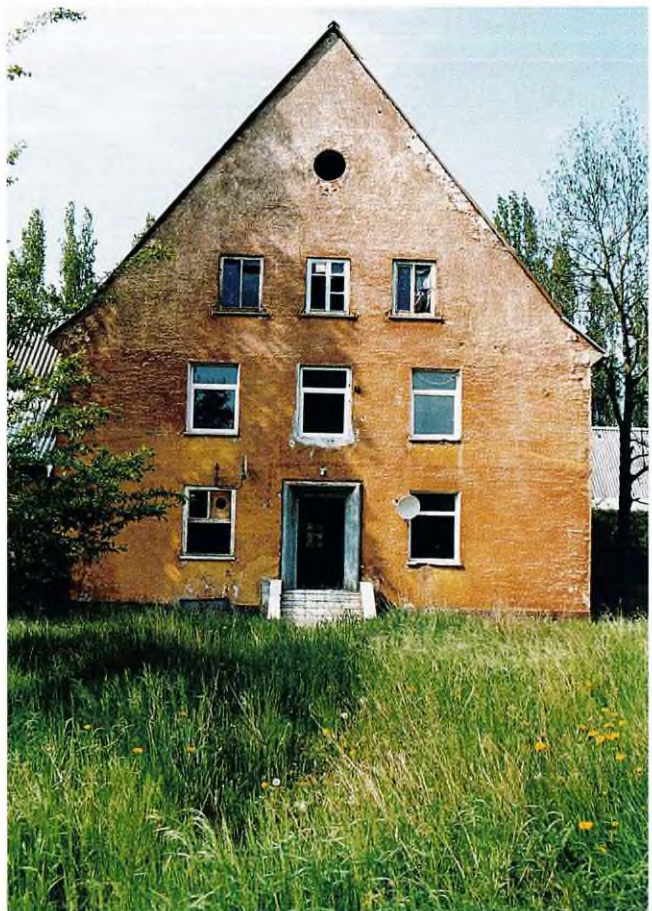
Flak-Kaserne an der Thomas-Mann-Straße, Stirnseite eines Mannschaftsgebäudes
