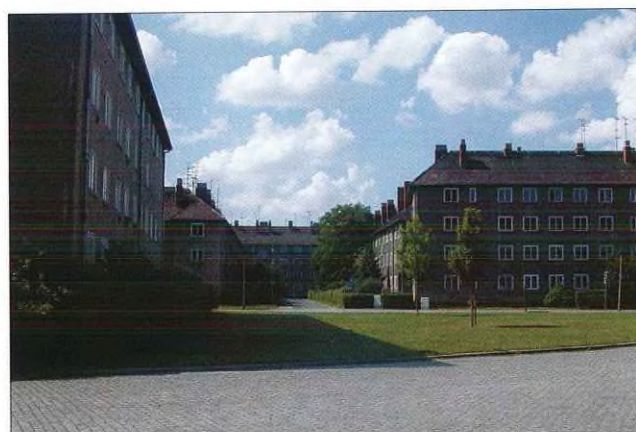
Der Bestand an leer stehenden und unsanierten Wohnungen besitzt auch in Alter und Neuer Neustadt Dimensionen, denen mit strategischen Überlegungen begegnet werden muss. Hier: Leer stehende Quartiere in der nördlichen Alten Neustadt
