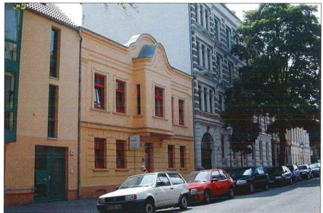
(oben) Saniertes Haus in der Moritzstraße, Neue Neustadt, (mittig) Hof zwischen sanierten und unsanierten Wohngebäuden nördlich der Heinrichstraße, Neue Neustadt, (unten) Störwirkung unsanierter Studentenwohnheime hinter der Ernst-Lehmann-Straße, Alte Neustadt
