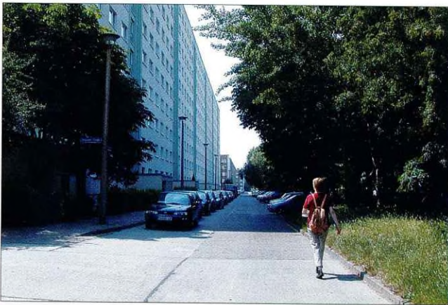
Bauhöhen charakterisieren wesentlich städtebauliche Teilräume. Hier: Blick in die Bebertaler Straße, Neue Neustadt
