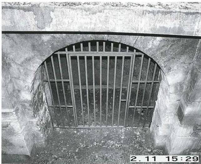
Abb. 53: Poternentor in der Eskarpenmauer des Rondells. Die Werksteine des Rundbogens mit Einbindung des Fugenschnitts in das Werksteingewände. © DuB 2004.
