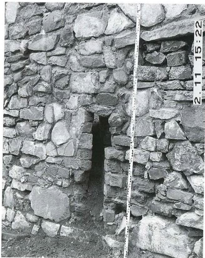
Kennzeichen der eher bauzeitlich einheitlich erscheinenden Brustwehr ist der um die Breite des Wehrganges zurückgesetzt anschließende Wall der Geschützplattform, vielmehr aber die alternierende Gliederung mit Schießscharten und Munitionsnischen
