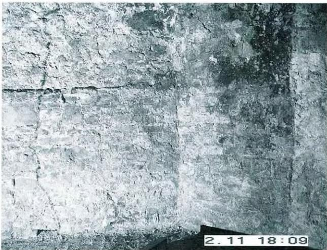
Abb. 30: Übergang der in Ziegel aufgeführten Tornische in das Widerlager des geraden Gewölbeganges, dort ein in der Wandflucht verspringender Stoß. © DuB 2004.
