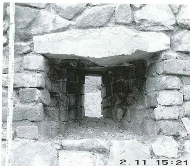
Abb. 46: Quadratische Schießnische mit scheinrechtem Sturz und gestufter Laibung. In gleicher Art ist der Schusstrichter in der Außenwand gestaltet. © DuB 2004.
