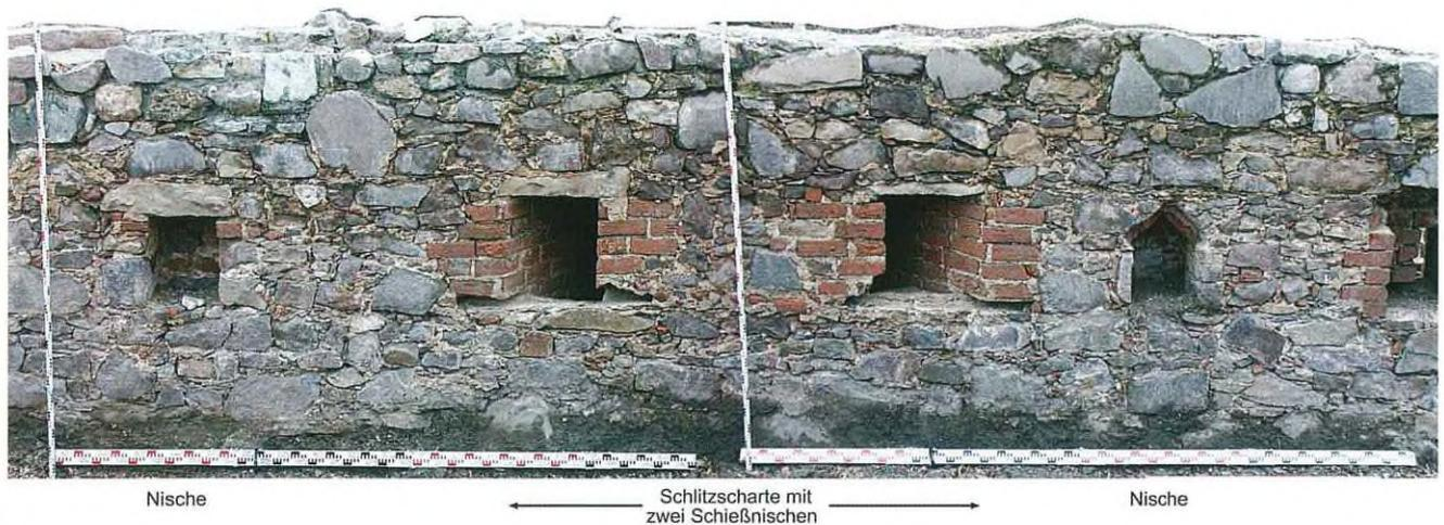
Abb. 51: Innenansicht der sekundären Brustwehr des Rondells mit Munitionsnischen und Schlitzscharte mit zweifachem Schießkanal und Schießnischen. Die Prellhölzer sind, wie erkennbar, sämtlich entfernt. © DuB 2004.
