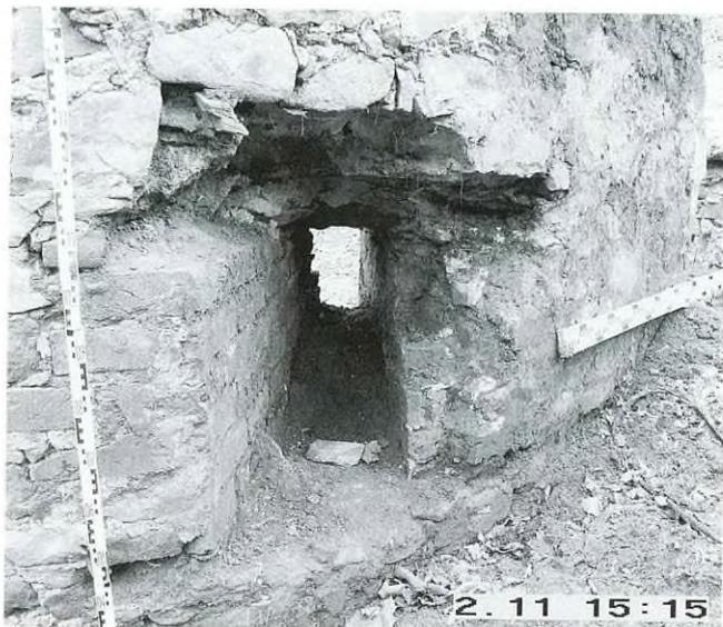
Abb. 43: Linke Schießnische einer doppelten Schießkanalscharte, deren Ziegeleckenverband in den Fluchtknick übergeht. © DuB 2004.
