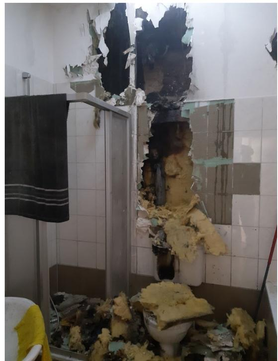
Die Brand- und Rauchausbreitung über die Zwischenwände erstreckt sich über drei Etagen und macht zwei Wohnungen unbewohnbar. Zur Restablösung und Sicherung der Brandstelle mussten große Teile der Gipskartonwände in zwei Wohnungen und Teilbereiche des Daches geöffnet werden. Die Feuerwehr war über vier Stunden vor Ort.
