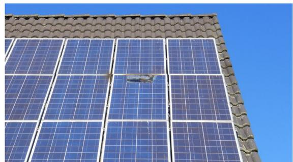
Durch Hinzuziehung einer Elektrofachkraft wurde das betroffene Panel aus der Anlage fachgerecht getrennt und vom Dach über die Drehleiter entfernt. Restlöscharbeiten wurden am Panel und dem auf der Dachhaut angesammelten Nistmaterial durchgeführt.
