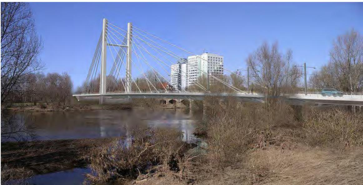
Abbildung 11: Farbkonzept Variante 2: Überbau DB702 | Seile grau | Gesimse grau / Beton
