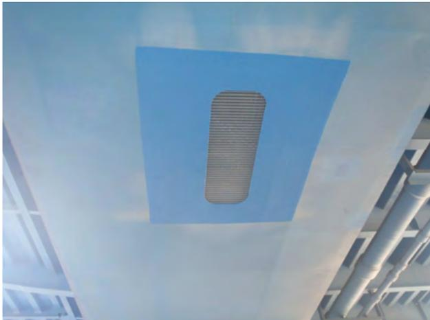
Abbildung 9: Auskreidung an der bestehenden Neuen Strombrücke
