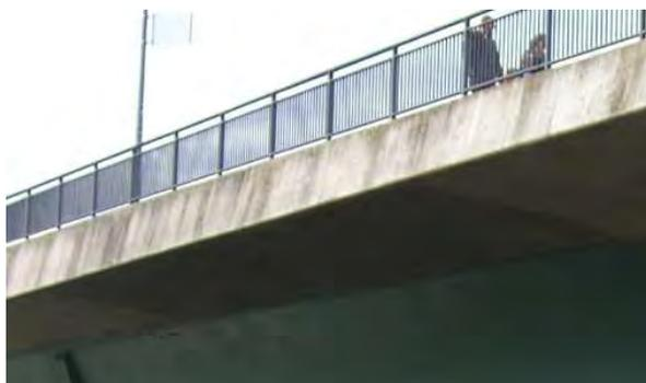
Abbildung 6: Verschmutztes nach außen geneigtes Kappengesims ohne Oberflächenbeschichtung
