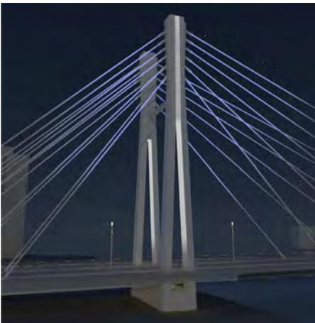
Abbildung 3: Farbige Seilanstrahlung von oben
