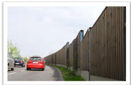
Es lassen sich durch Lärmschutzwände hohe Abschirmungen bis zu 20 dB(A) erzielen. Voraussetzung ist jedoch, dass die Sichtverbindung zwischen Quelle (Fahstreifen) und Immissionsort (Fassade/Fenster) unterbrochen ist. Die Bild 10 stellt die Schallpegelminderung durch Schallschutzwände dar.
