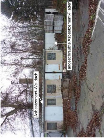
Bild 21: Lagerschuppen (H) mit AZ-Welldach und AZ-Fassadenverkleidung
