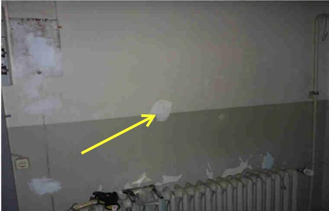
Bild 1: Entnahmestelle Wandfarbe
