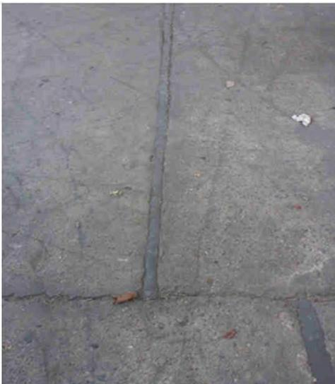
Bild 2: Fugenmassen in Lagerhalle
