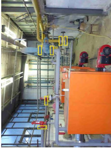
Bild 28: Innenraum Heizhaus, farbig markiert: IT-Dichtungen
