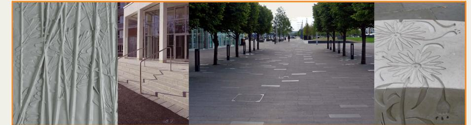
DIE OBERFLÄCHEN DER MAUERN BEKOMMEN DURCH STRUKTURMATRIZEN EINEN BESONDEREN CHARAKTER. IDEE: 'NOE PLAST' 'BAMBUS'
