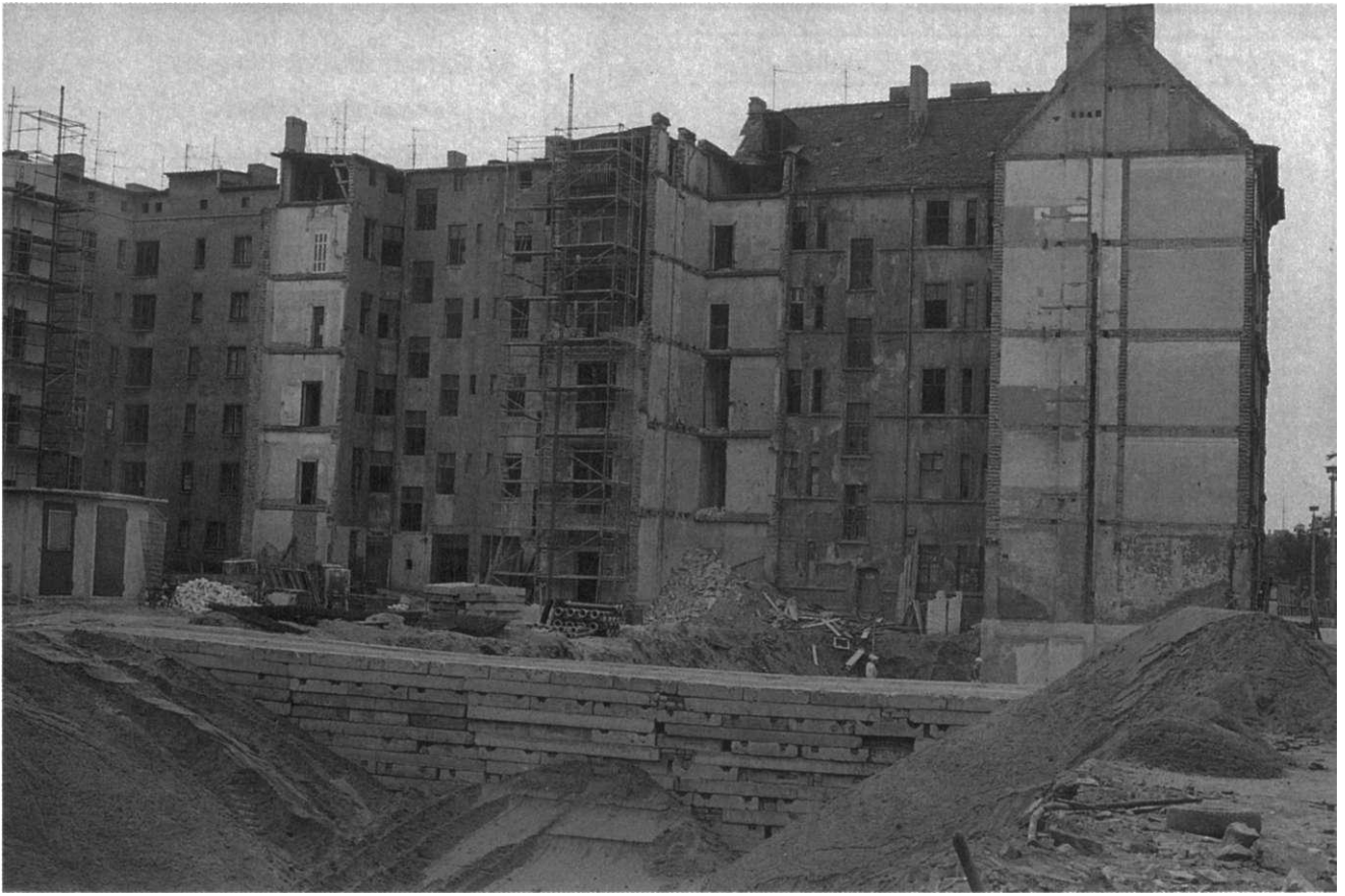
Leibnizstraße vom Hof gesehen während der Umgestaltung. 1987/88
