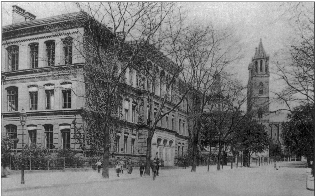
Dom Gymnasium, Augustastraße (Hegelstraße 5)
