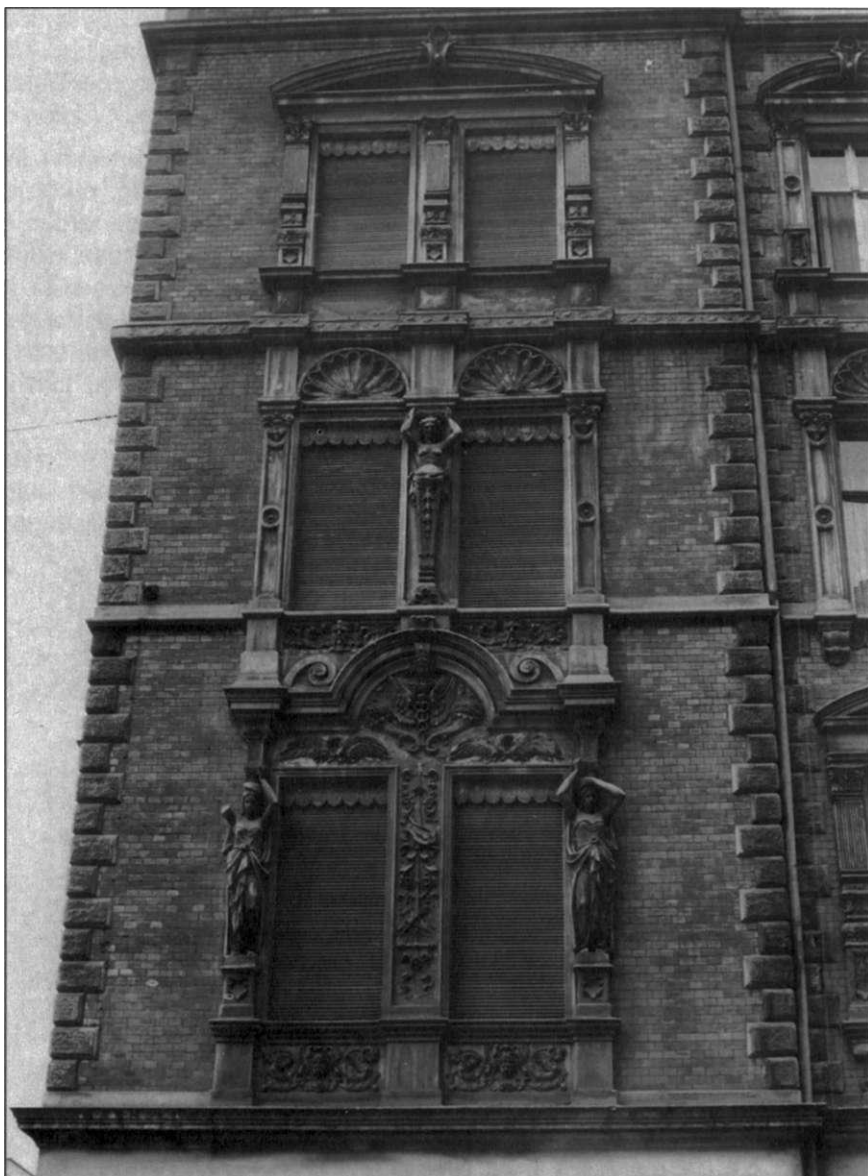
Fassadendetail, Breiter Weg 227/Ecke Keplerstraße
