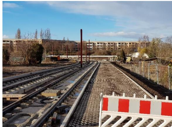
Abb. 46: Gleistrasse mit Unterhaltungsweg der 2. Nord-Süd-Verbindung der Straßenbahn (eigenes Foto)
