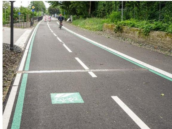
Abb. 6: RS1 in Mühlheim/Ruhr mit Randmarkierung in „Verkehrsgrün“, Stand der Technik in 2019 (eigenes Foto)
