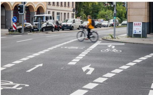
Abb. 22: Aufstellbereich für indirektes Linksabbiegen mit separatem Signalgeber für den Radverkehr in Leipzig (eigenes Foto)
