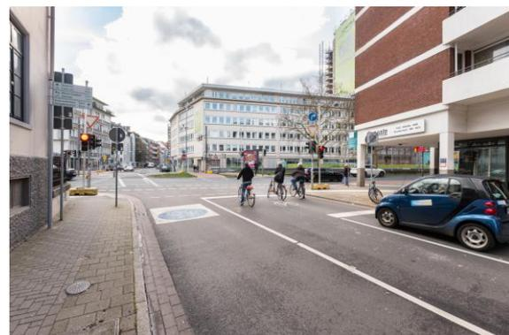
Abb. 23: Aufgeweiteter Radaufstellstreifen in Bremen (eigenes Foto)
