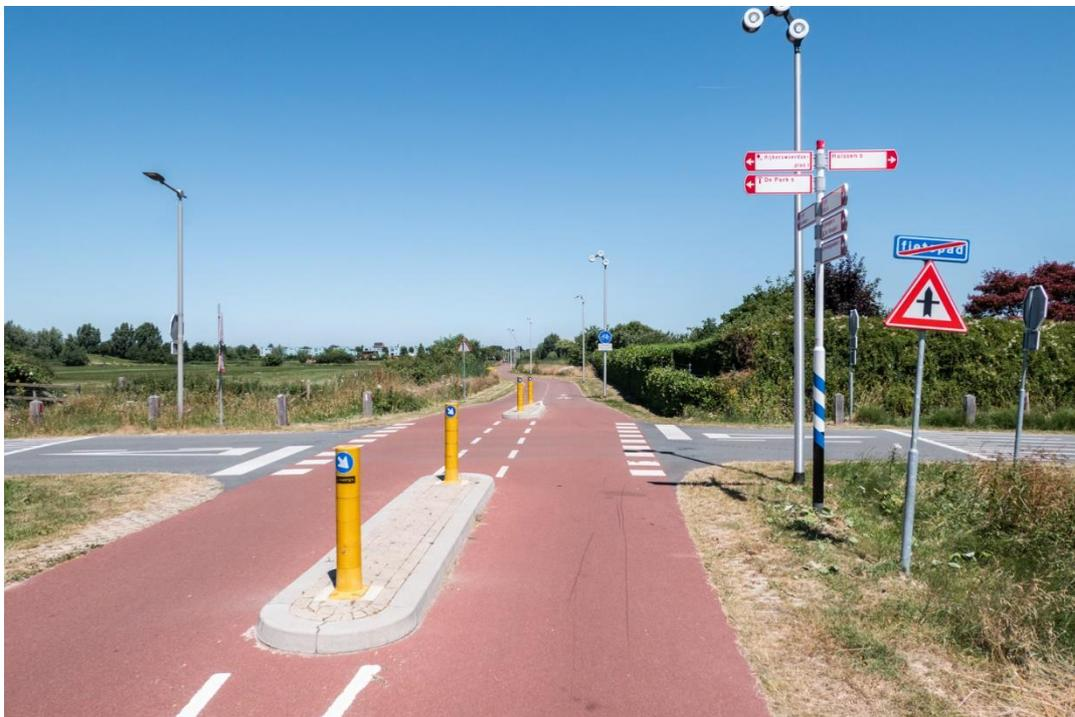
Abb. 1: Radschnellweg Arnhem-Nijmegen (NL). Bevorrechtigte Führung am Knotenpunkt ohne separaten Gehweg (eigenes Foto).
