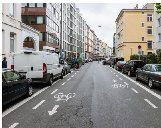
Abb. 14: Einsatz von Piktogrammreihen in Fahrradstraßen in Verbindung mit Sicherheitstrennstreifen zu Parkständen in Frankfurt am Main (eigenes Foto)
