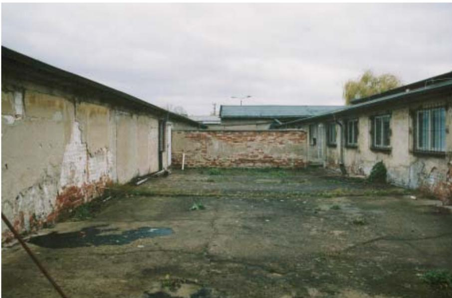
*Östliche Stallanlagen. Mittlerer Hof. Ansicht nach Süden. Sowohl an den äußeren als auch an den inneren Ställen sind Mauerwerk und Putz in schlechtem Zustand. Die Feuchteschäden resultieren nicht zuletzt auch aus der Versiegelung des Innenhofes durch Betonaufbau.*
