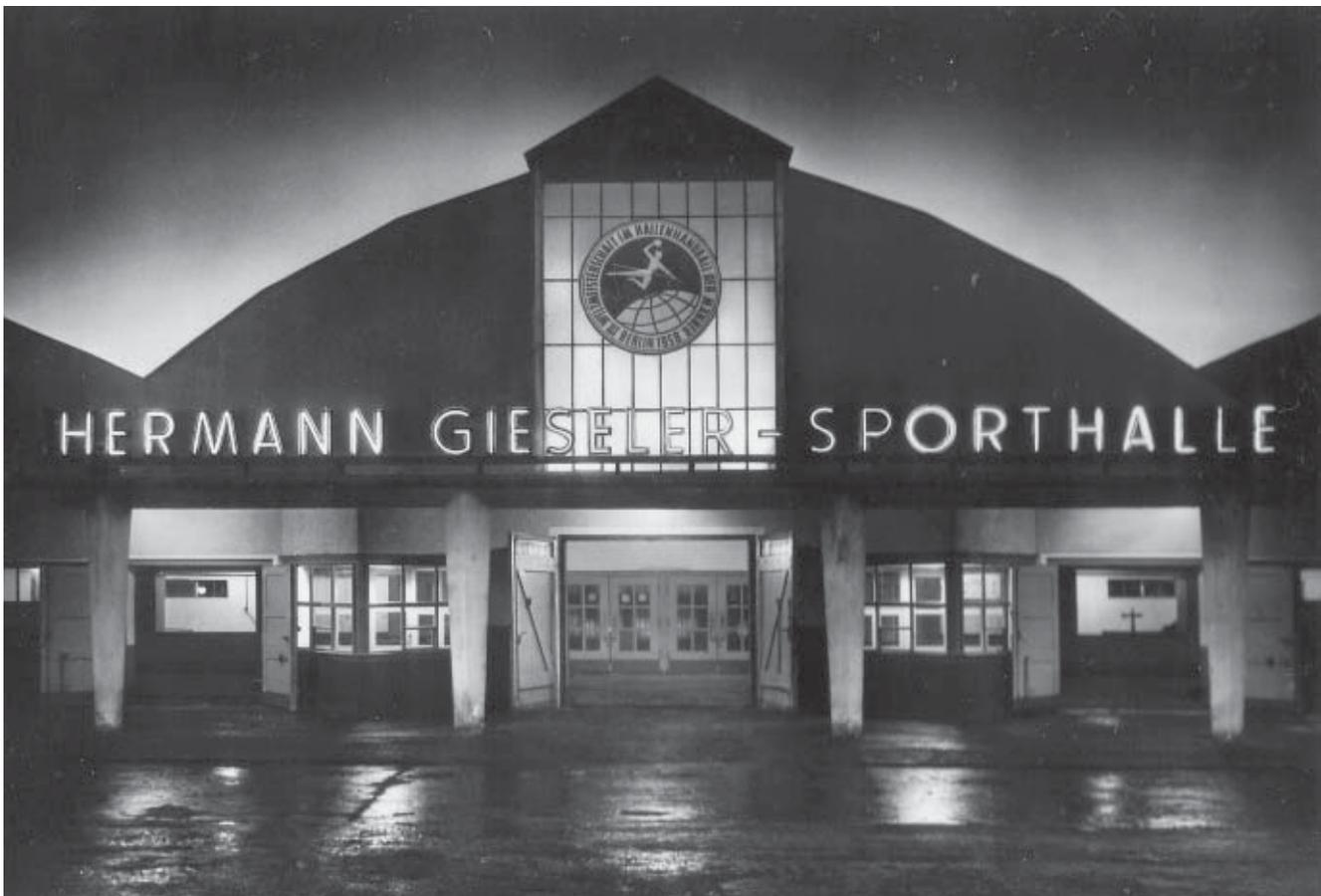
*Ansicht des Eingangsbereiches im Norden. Das hohe Fenster liegt flach in der Wand, ihm fehlt die Verbindung zum abgebrochenen Oberlicht. Störend sind die beiden runden Lüftungsöffnungen rechts und links des Fensters. An den seitlichen Wänden wurden die runden Fensteröffnungen zugunsten rechteckiger, die auch in ihrer Höhe verspringen, verändert.*
