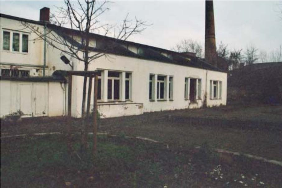
*Südlicher Anbau. Auch an den Längswänden im südlichen Bereich wurden die runden Fenster zugunsten rechteckiger, die in ihrer Höhe verspringen, abgebrochen. Die Erhöhung in der Dachfläche markiert den ursprünglichen Haupteingang.*
