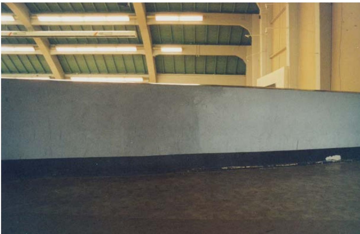
*Halleninneres. Südempore. Die in unterschiedlicher Qualität und verschiedenen Zeiten ausgeführte Brüstung zeigt den Beginn der ursprünglich hier verlaufenden Südempore.*
