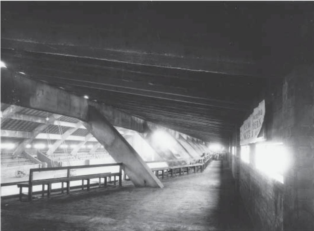
*Blick in den Innenraum der Halle während der Malerarbeiten. Gut sichtbar ist die erste Konstruktion und Anordnung der Sitzreihen, die bis hinter die Bogenbinder der Stahlbetonkonstruktion reichten.*
