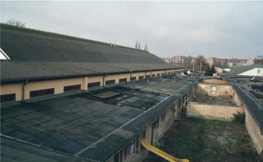
*Östliche Stallanlagen. Mittlerer Innenhof. Ansicht nach Norden. Im mittleren der heute insgesamt drei Innenhöfe verbindet ein nachträglich eingefügter Gang die äußeren und inneren Ställe. Auf den gepflasterten Boden des Innenhofes ist Beton aufgebracht. Keines der Fenster ist erhalten.*
