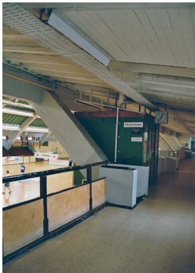
*Halleninneres. Ostempore. Den Raum prägen die Stahlbetonkonstruktion sowie die seitlichen, innen mit einem Gitter versehenen Fensterbänder. Das Geländer oberhalb der Sitzreihen ist eine bauliche Neuerung von 1958.*
