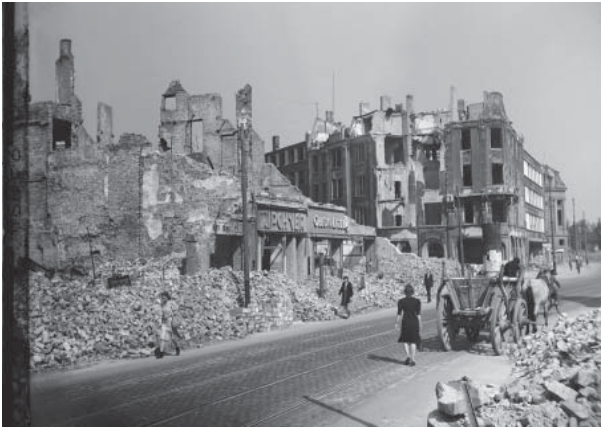
Der Abschnitt vom Theater (rechts hinten) bis etwa zur Höhe Breiter Weg 118.
