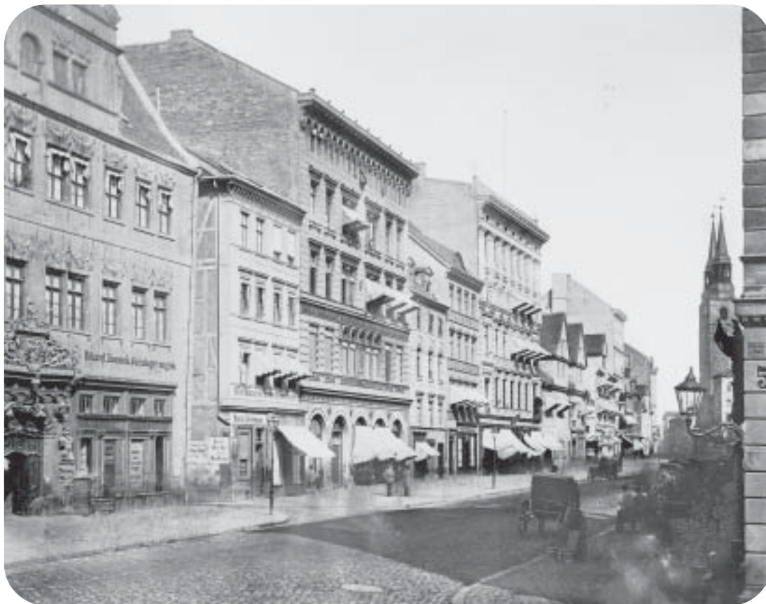
Blick von der Straßenecke Eingang Alter Markt nach Nordwesten
