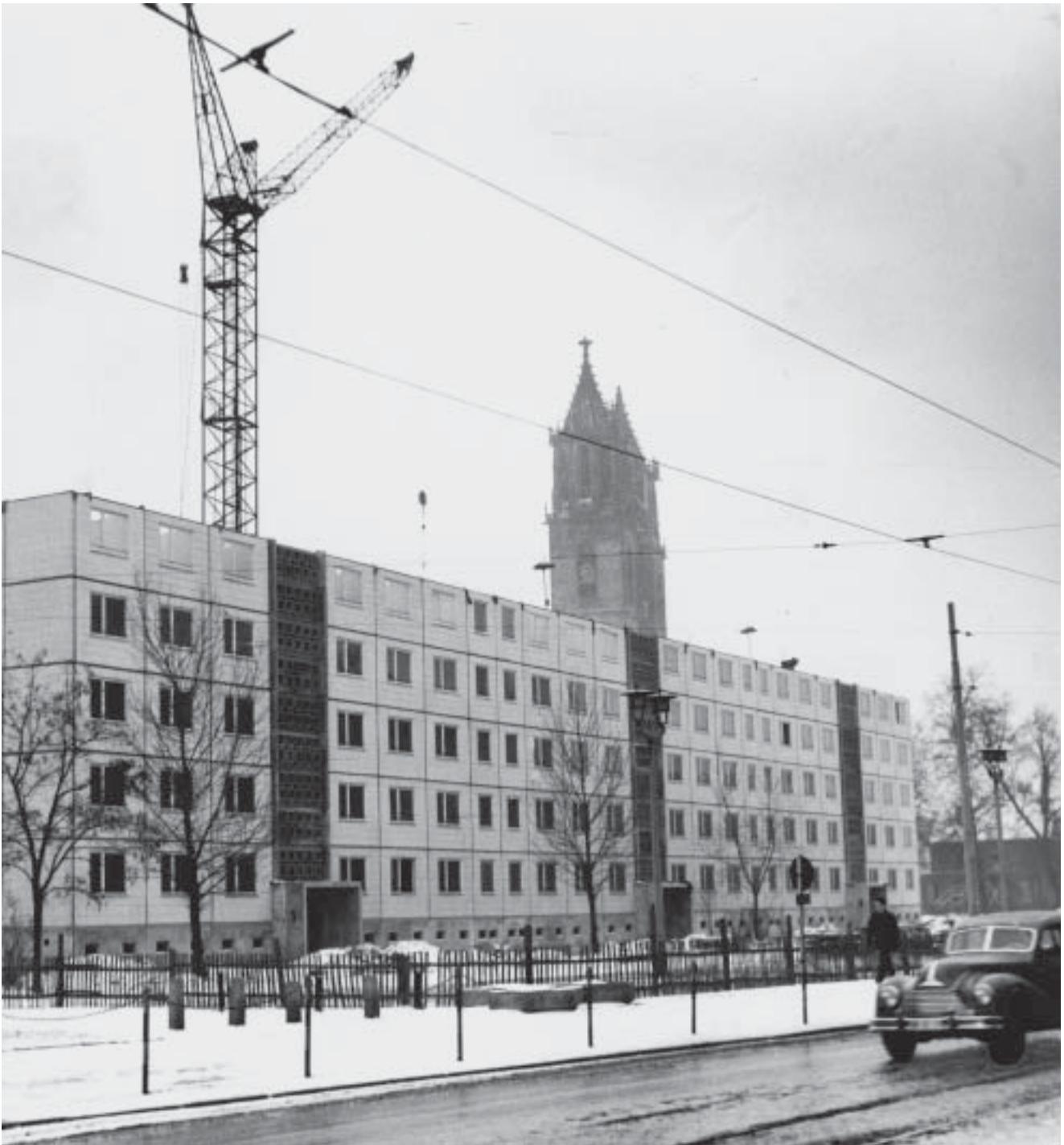
Bau des Achtgeschossers gegenüber der Leiterstraße, 26.2.1965
