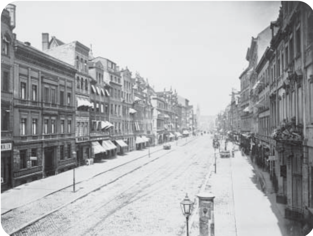
Blick von der Steinstraße 1 nach Norden
