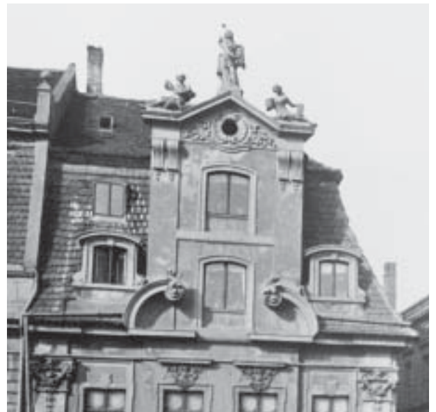
Breiter Weg 165, Dachaufbau
