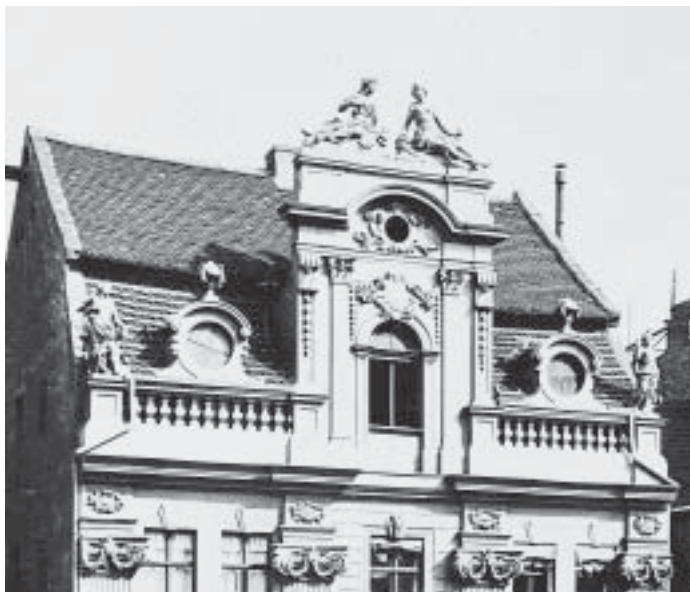
Breiter Weg 29, Dachaufbau
