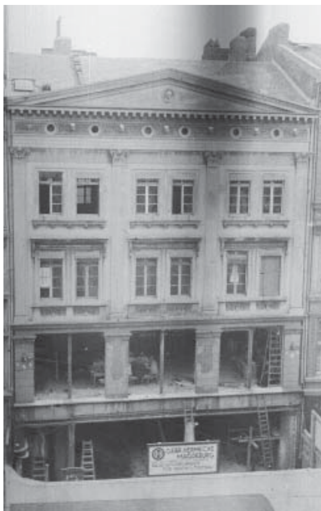
Breiter Weg 40 während des Umbaus Ende September 1932
