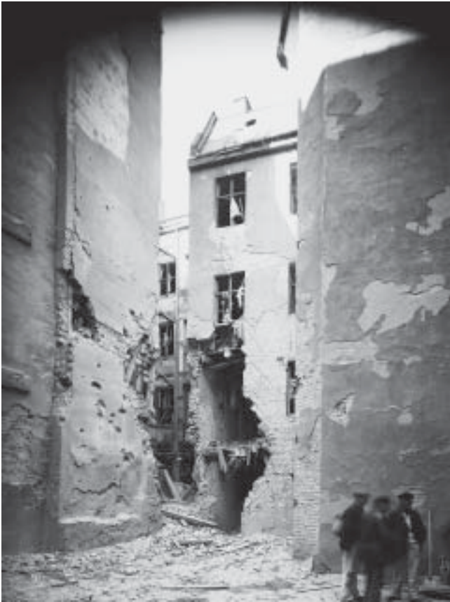
Breiter Weg 82, Bombenschäden 18.4.1941
