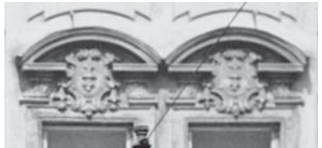
Breiter Weg 178, Fensterverdachung
