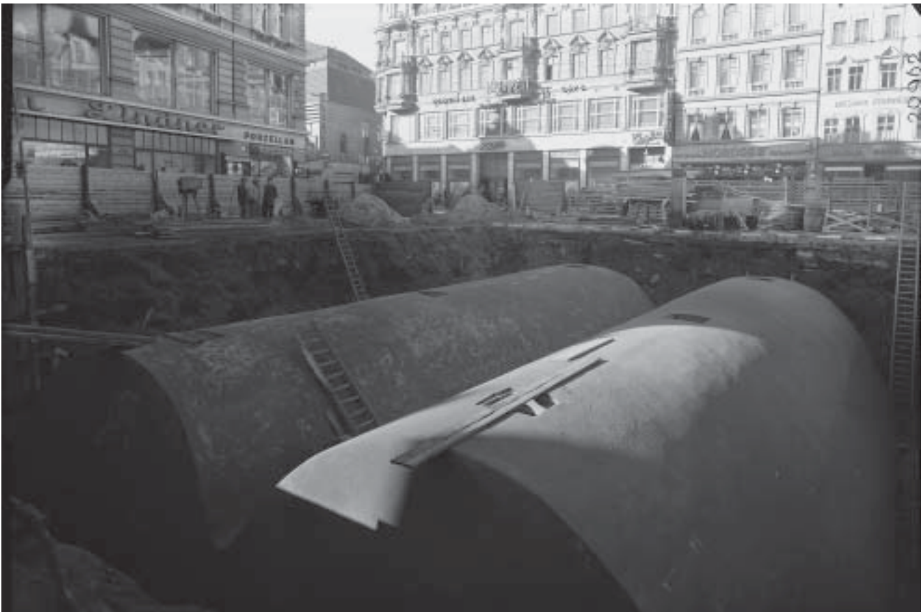
Bau der Zisterne auf dem Ratswaageplatz, 27.10.1941
