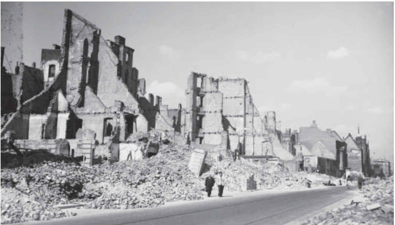
Im Hintergrund rechts die Post und die erhaltenen Gebäude Breiter Weg 212 und 212 a. Vor der Litfaßsäule kreuzt die Oranienstraße (heute Danzstraße), vom links (bei den beiden Männern) zweigt die Anhaltstraße ab.
