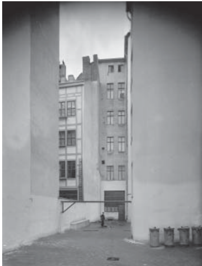
Fertigstellung der Instandsetzung 10.11.1941
