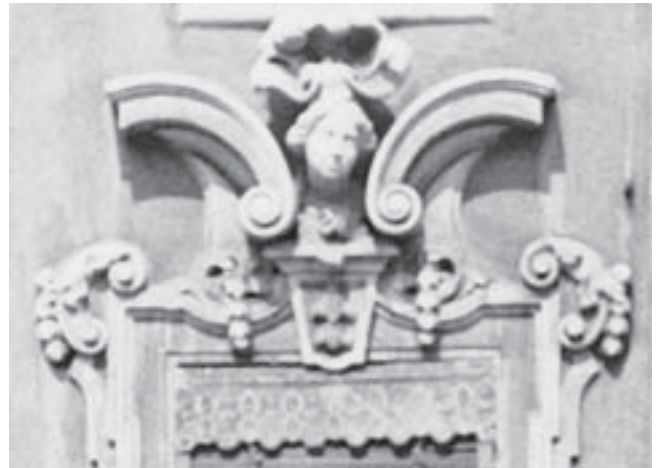
Breiter Weg 179, Fensterverdachung
