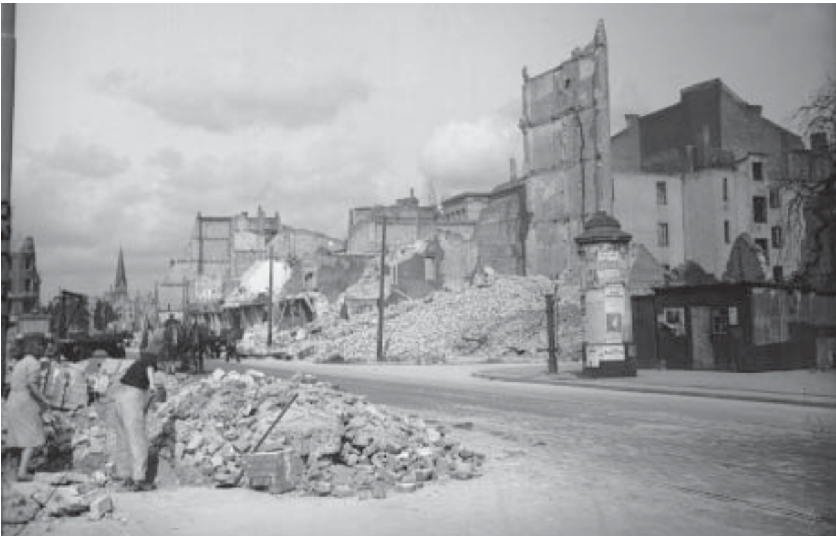
Der Abschnitt nördlich der Katharinenkirche.
