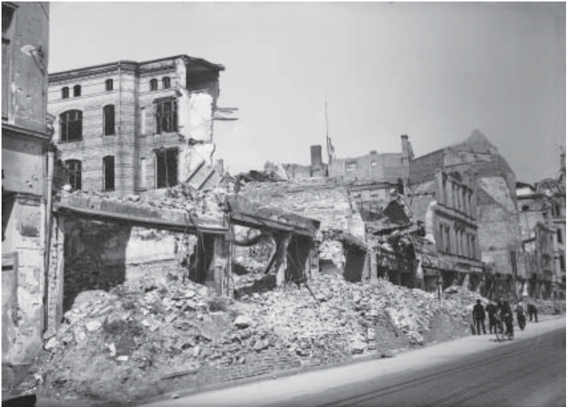
Der Abschnitt von der Himmelreichstraße (rechts) bis zum Beginn des Engpasses.
