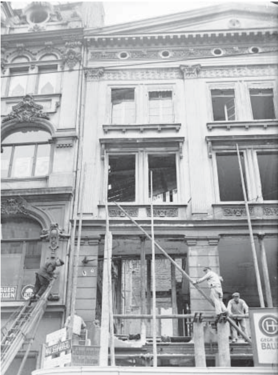
Breiter Weg 40 während des Umbaus Anfang Oktober 1932
