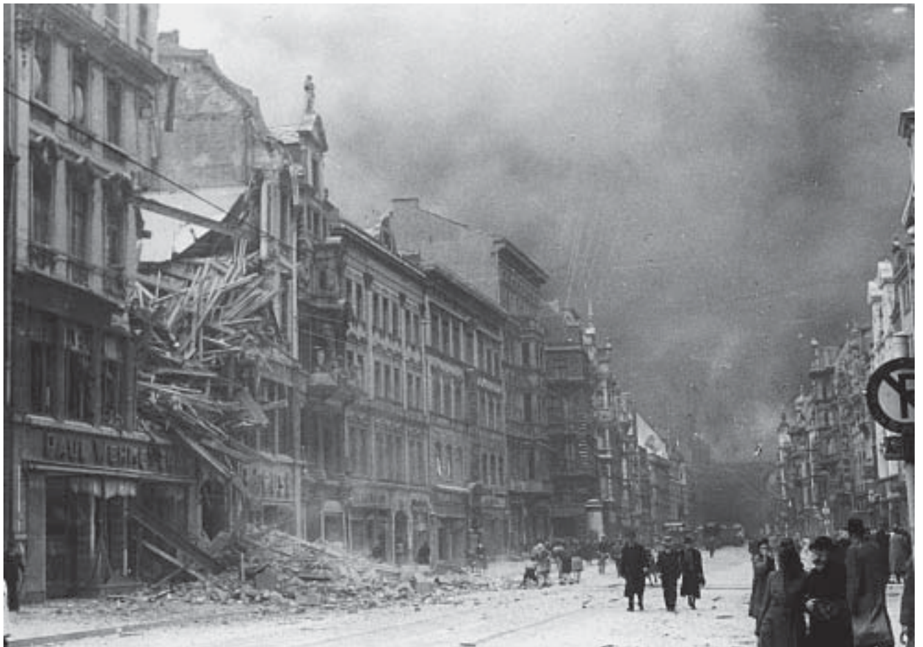
Der Breite Weg nach dem Angriff vom 28. September 1944, links Breiter Weg 175-177, im Hintergrund die brennende Katharinenkirche
