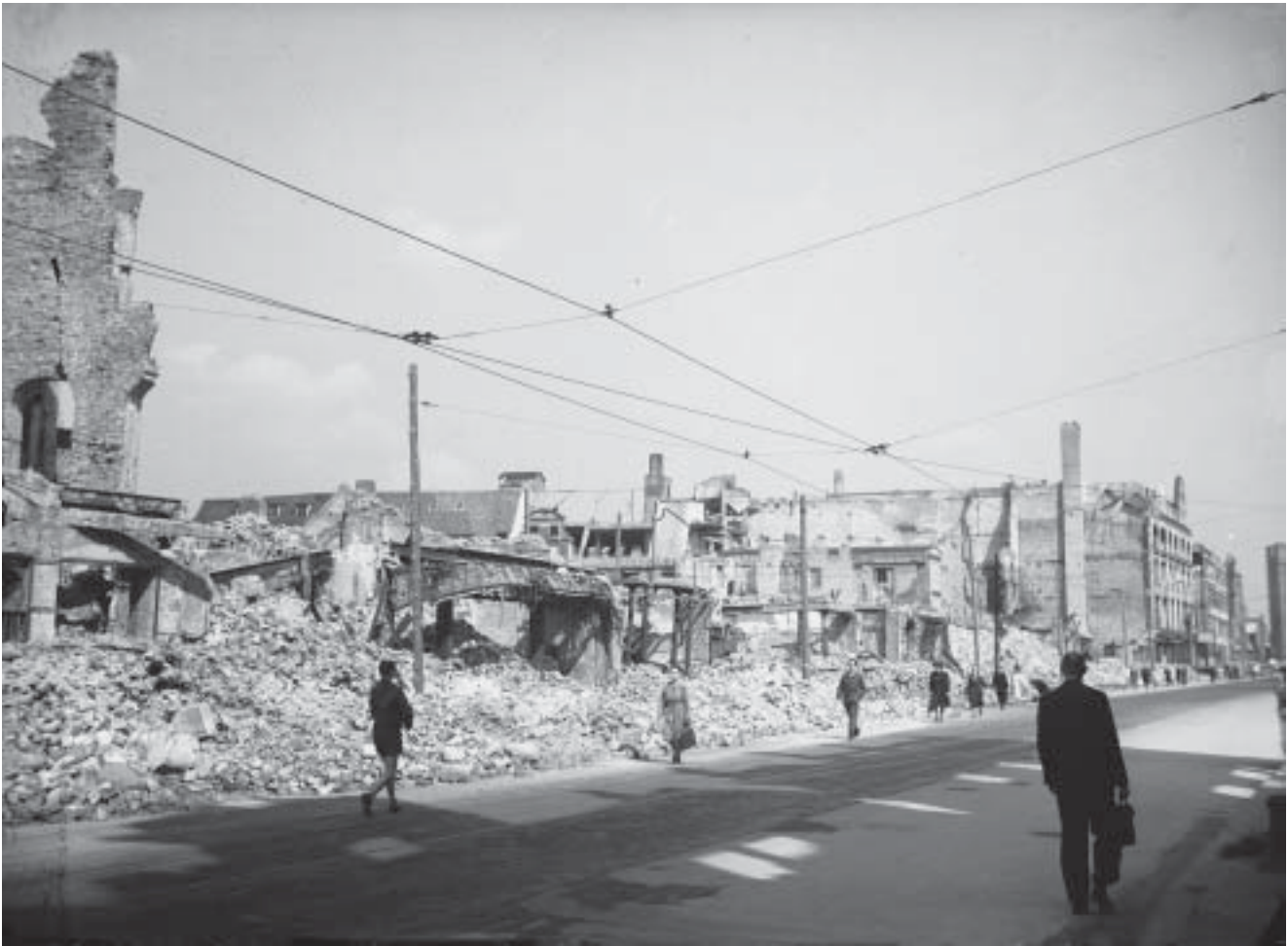
Links die Reste des „Warmen Lochs“ (Breiter Weg 165), rechts die Kaufhausruinen Steigerwald & Kaiser und Lemke. Im Hintergrund sind die Dächer der Hintergebäude der Mittag AG (Breiter Weg 155) zu erkennen. Die beschädigten Dächer werden gerade neu gedeckt. Die Gebäude in der früheren Weinaßstraße bildeten noch bis in die 60er Jahre die nördliche Straßenfront der Wilhelm-Pieck-Allee und wurden erst wegen des Baus des „Blauen Bocks“ abgerissen.
